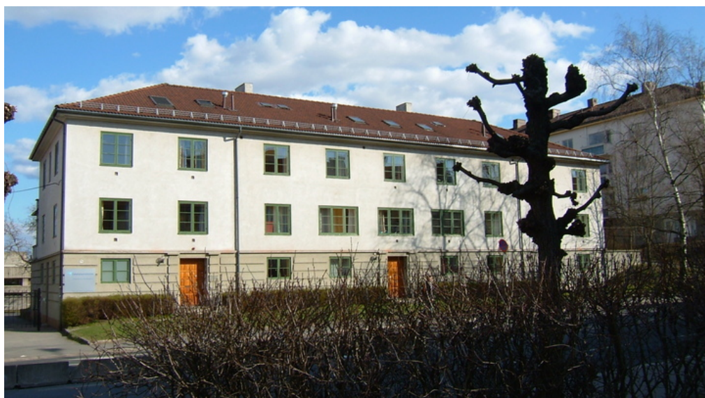
Fasade mot Geitmyrsveien Foto: Leif Maliks, Forsvarsbygg.
