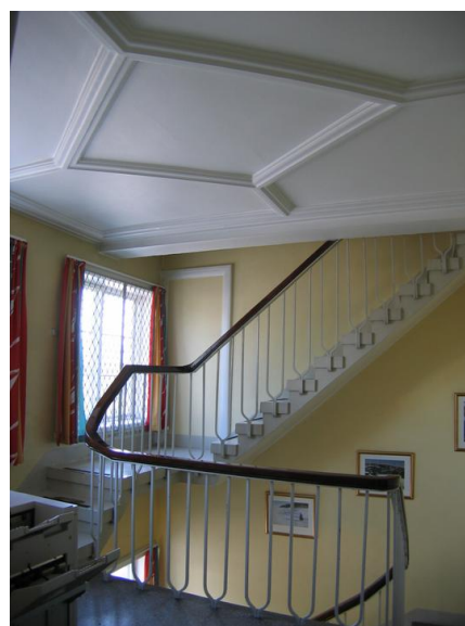
Trapperom Foto: Lasse Kaas Opphavsrett: Statsbygg
