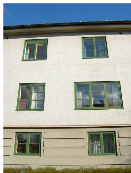
Fasadedetalj Foto: Leif Maliks, Forsvarsbygg.
