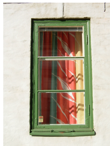
Originalvindu Foto: Leif Maliks, Forsvarsbygg.
