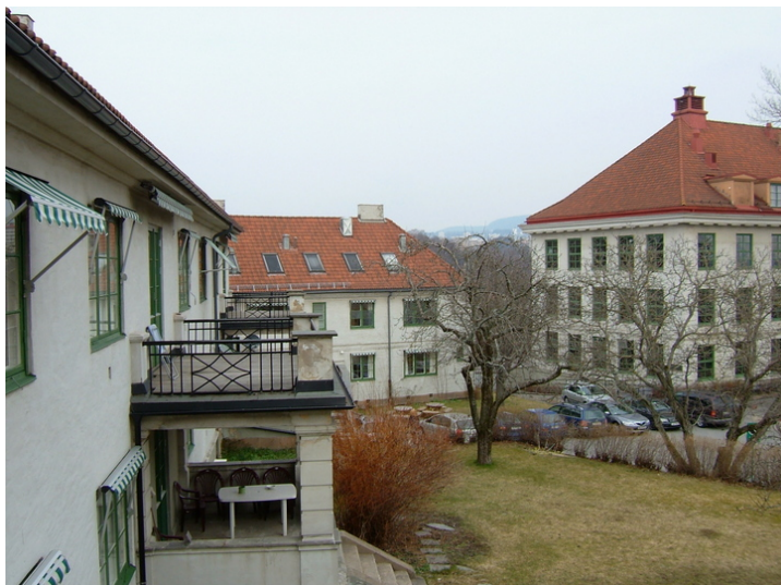
Kontorvillaen, hjørnebygget og den gamle hovedbygningen. Foto: Leif Maliks, Forsvarsbygg.
