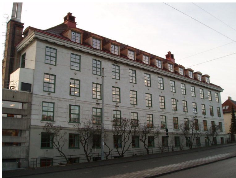
Fasade mot Griffenfeldts gate
