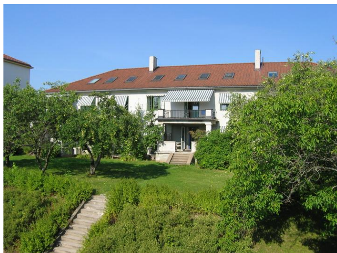
Fasade gårdsrom Foto: Lasse Kaas Opphavsrett: Statsbygg
