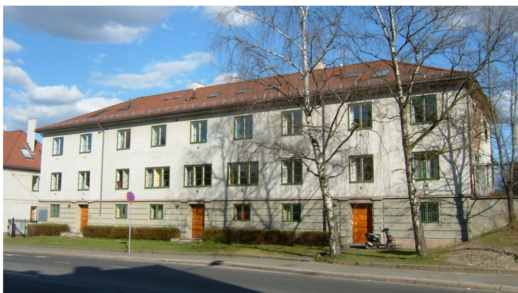
Fasade mot Geitmyrsveien Foto: Leif Maliks, Forsvarsbygg.
