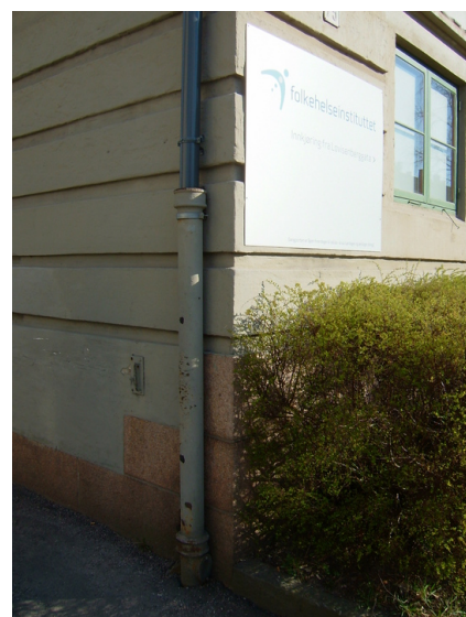
Hjørne med huggen sten Foto: Leif Maliks, Forsvarsbygg.
