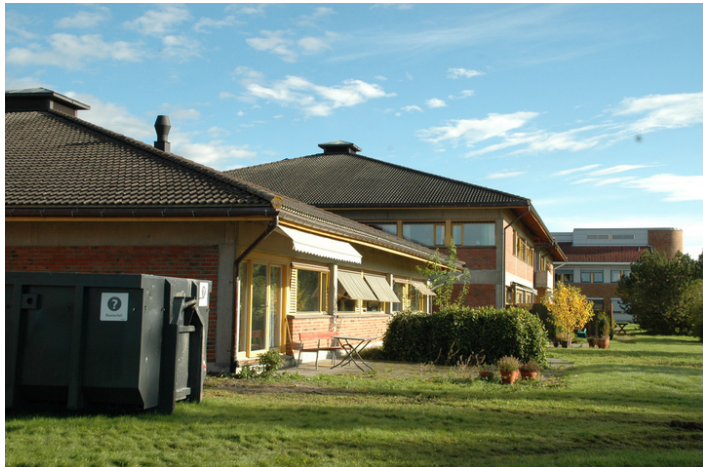
W-bygningen foran, med V og T i bakgrunnen. Foto: Marte Oftedal, Forsvarsbygg.
