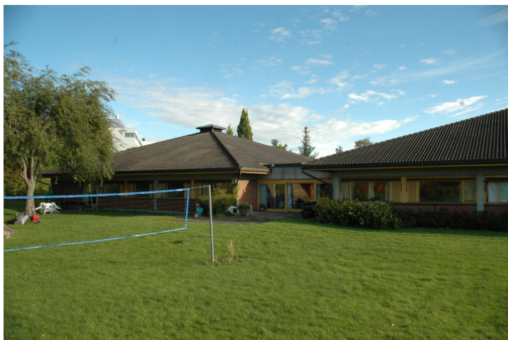
L-bygningene sett fra vest. Foto: Marte Oftedal, Forsvarsbygg.
