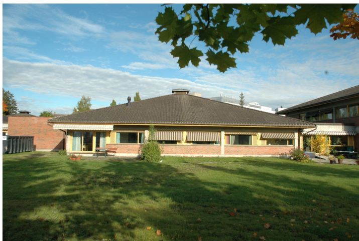
W-bygningen sett fra sør-sørøst. Foto: Marte Oftedal, Forsvarsbygg.
