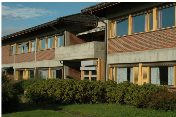
Bygningen sett fra sør-øst. Foto: Marte Oftedal, Forsvarsbygg.
