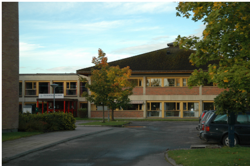
S-bygningen fra øst. Foto: Marte Oftedal, Forsvarsbygg.
