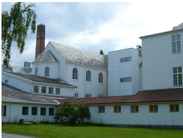
Fra baksiden, med kapellet litt til venstre. Foto: Leif Maliks, Forsvarsbygg.
