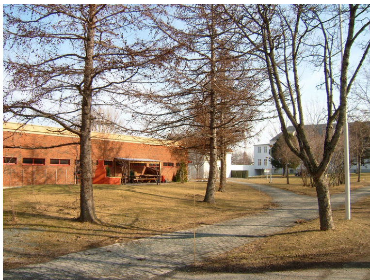
Deler av anlegget sett fra sørvest. Foto: Leif Maliks, Forsvarsbygg.
