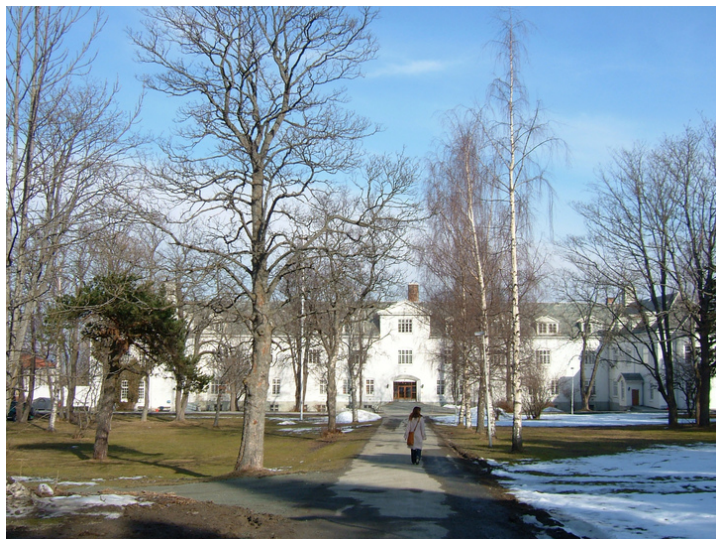
Hovedbygget mot hovedinngangen. Foto: Leif Maliks, Forsvarsbygg.
