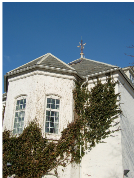
Eksempel på karnappene på sørsiden av bygningen. Foto: Leif Maliks, Forsvarsbygg.
