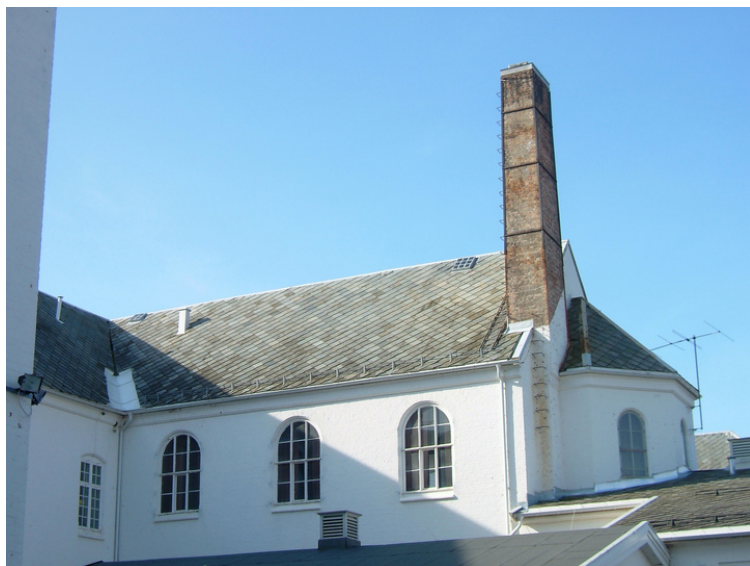
Baksiden, med kapellet og pipa, sett fra øst. Foto: Leif Maliks, Forsvarsbygg.
