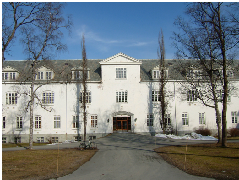
Hovedinngangen sett fra sør. Foto: Leif Maliks, Forsvarsbygg.
