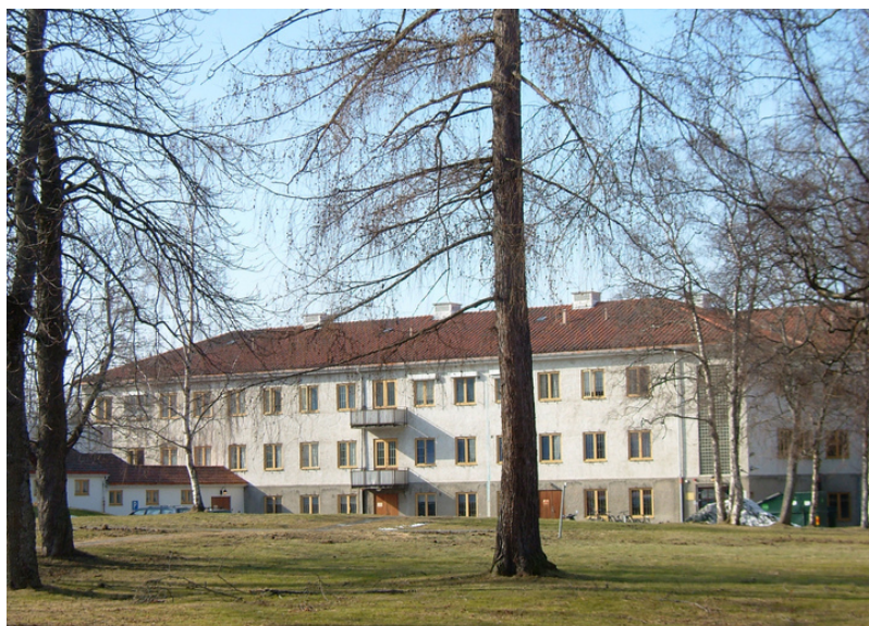
Sykeavdelingen sett fra øst. Foto: Leif Maliks, Forsvarsbygg.
