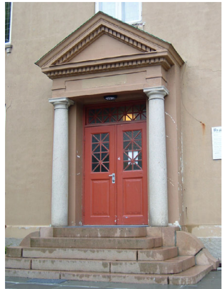
Inngangspartiet. Foto: Leif Maliks, Forsvarsbygg.
