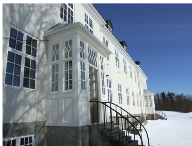
Sørfasaden av bygg 4. Foto: Leif Maliks, Forsvarsbygg.
