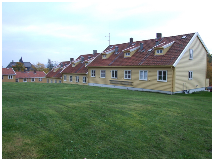
Boliger på Østmarka. Bygg 41 nærmest. Foto: Leif Anker, Forsvarsbygg.
