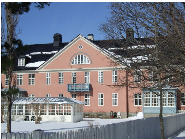
Bygning 6, med paviljongen foran, sett fra sørøst. Foto: Leif Maliks, Forsvarsbygg.
