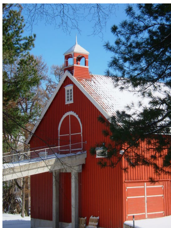
Nordgavlen. Foto: Leif Maliks, Forsvarsbygg.
