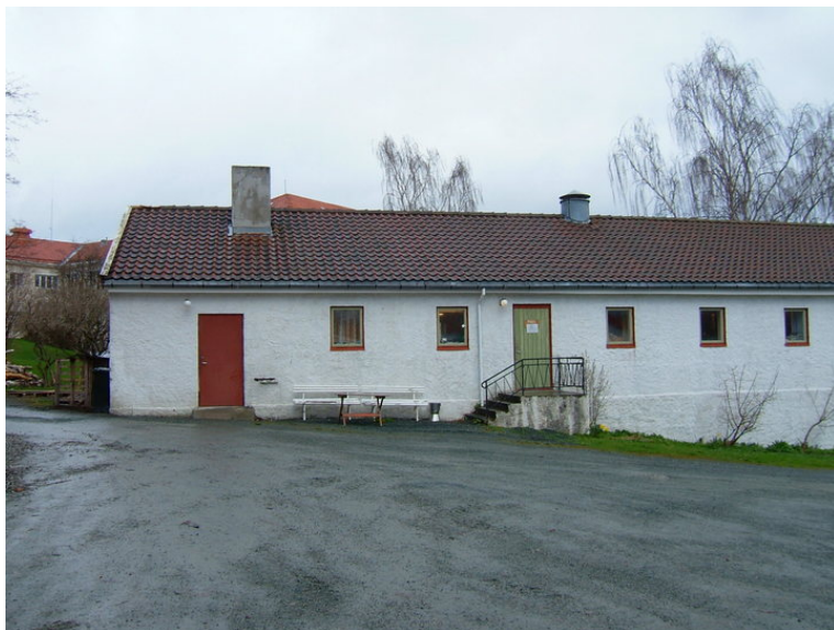
Grisehuset. Foto: Leif Maliks, Forsvarsbygg.
