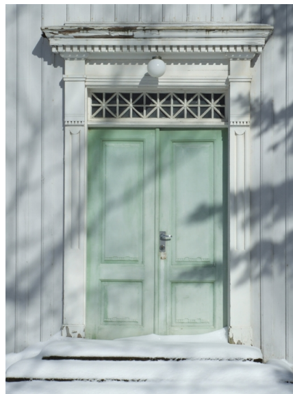
Inngangspartiet. Foto: Leif Maliks, Forsvarsbygg.
