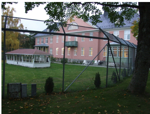
Sørfasaden. Foto: Leif Anker, Forsvarsbygg.
