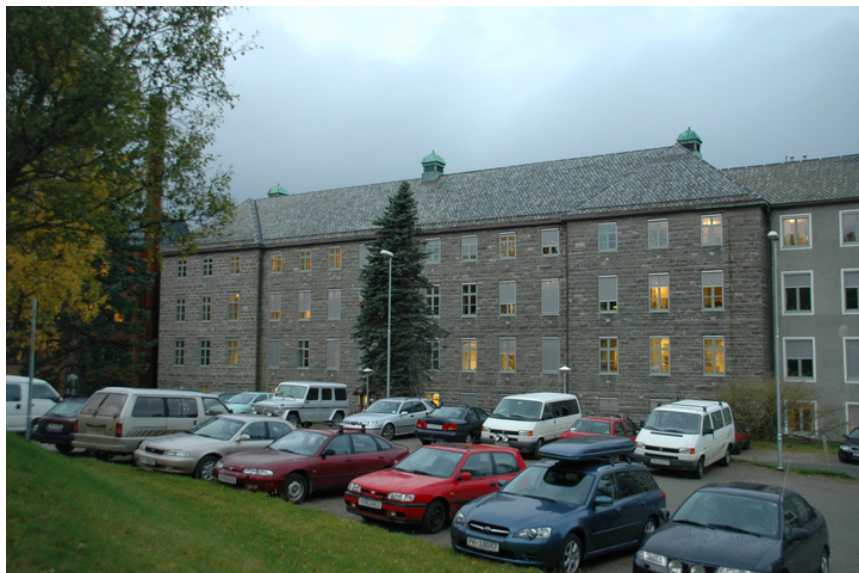
Gamle hovedfløy sett fra sørøst. Foto: Marte Oftedal, Forsvarsbygg.
