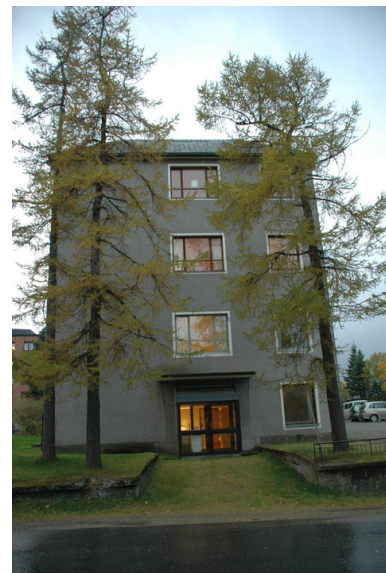
Fasade øst 1950-tallsfløy. Foto: Marte Oftedal, Forsvarsbygg.
