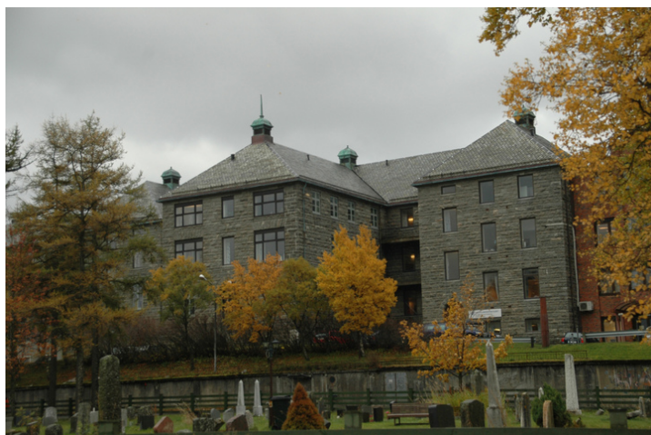
Gammelsykehuset sett fra nord. Foto: Marte Oftedal, Forsvarsbygg.
