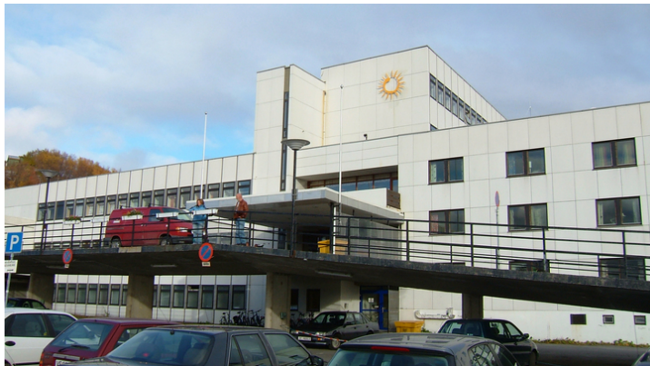
Nåværende hovedinngang til sykehuset. Foto: Leif Maliks, Forsvarsbygg.
