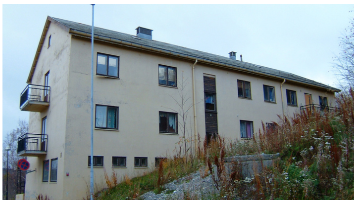
Bygningen sett fra øst. Foto: Leif Maliks, Forsvarsbygg.
