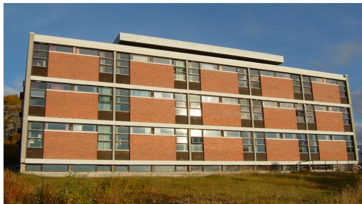
Bygningen sett mot øst. Foto: Leif Maliks, Forsvarsbygg.
