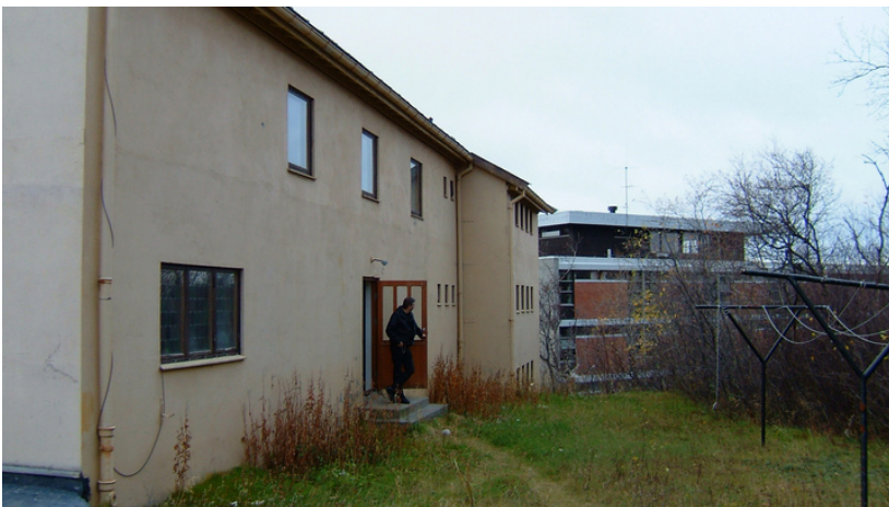
Baksiden av bygget, med elevhjemmet bak. Foto: Leif Maliks, Forsvarsbygg.
