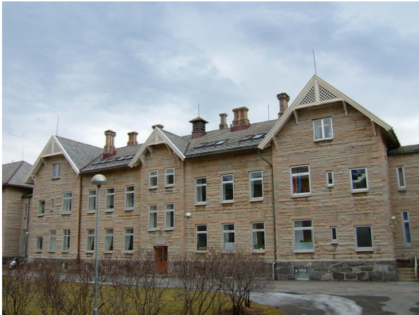
Foto: Leif Maliks, Forsvarsbygg.
