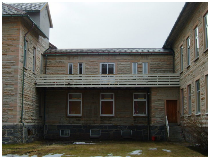
Foto: Leif Maliks, Forsvarsbygg.
