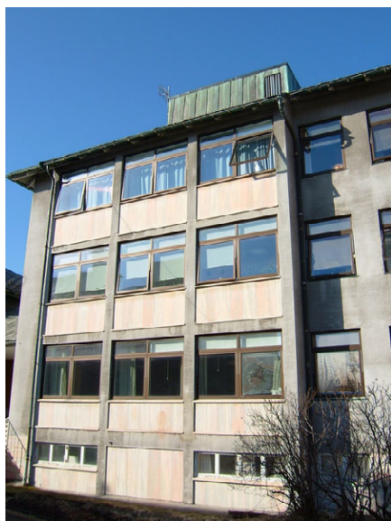
Foto: Leif Maliks, Forsvarsbygg.
