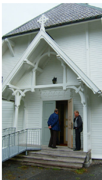
Kapellets inngangsdører. Foto: Leif Maliks, Forsvarsbygg.
