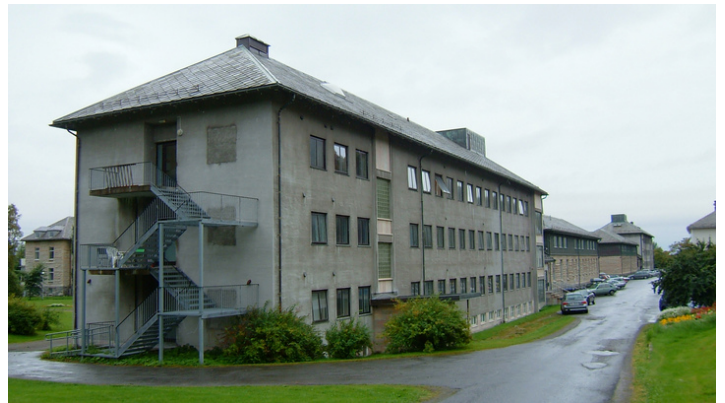
En av 1959-fløyene sett fra nordøst. Foto: Leif Maliks, Forsvarsbygg.
