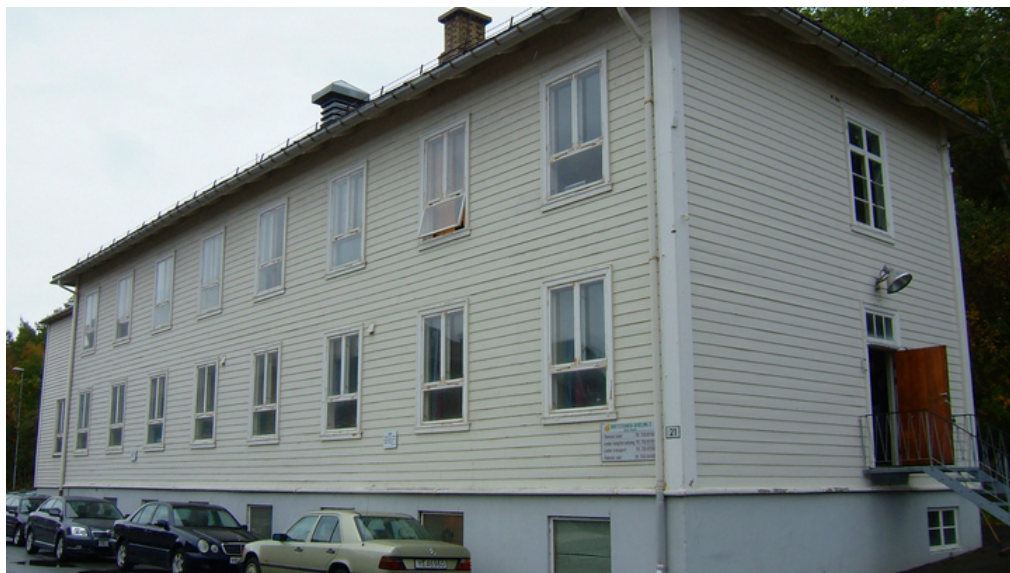
Sør- og østfasaden. Merk vinduene. Foto: Leif Maliks, Forsvarsbygg.
