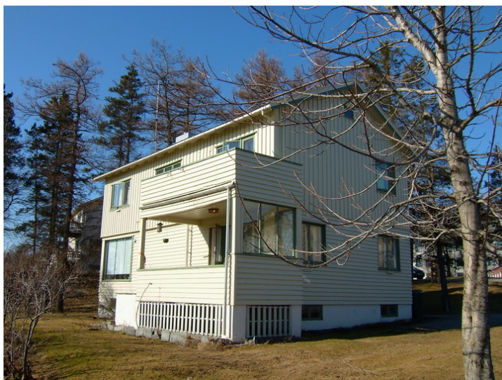
Huset sett fra sørøst. Foto: Leif Maliks, Forsvarsbygg.
