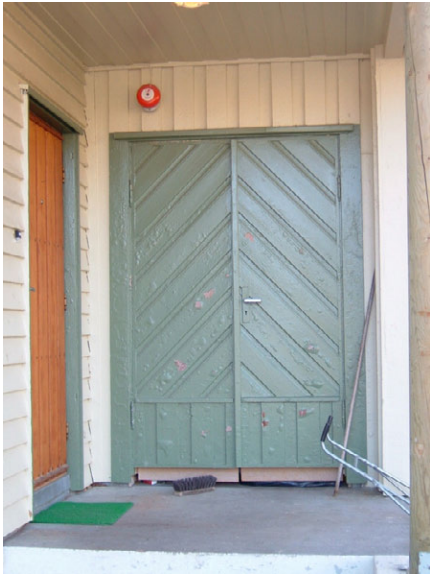
Detalj fra inngangspartiet. Foto: Leif Maliks, Forsvarsbygg.
