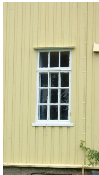
Detalj, vindu. Foto: Leif Maliks, Forsvarsbygg.
