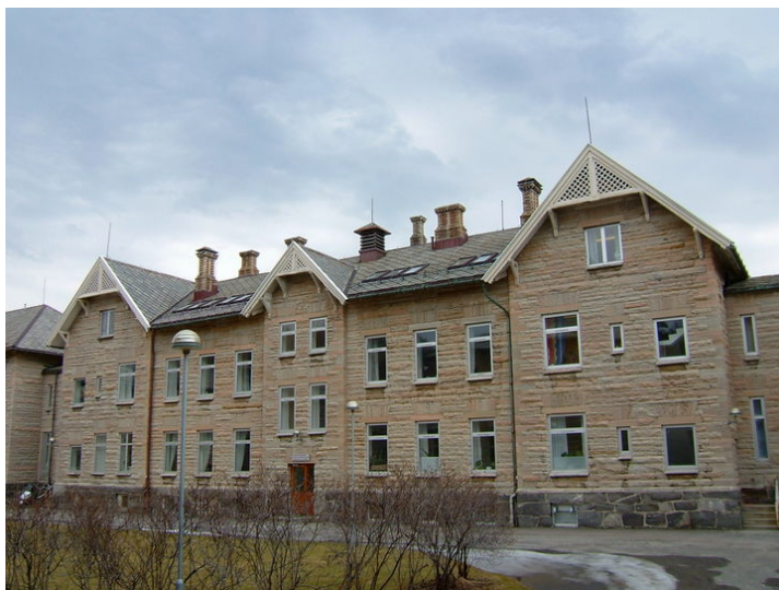
Foto: Leif Maliks, Forsvarsbygg.
