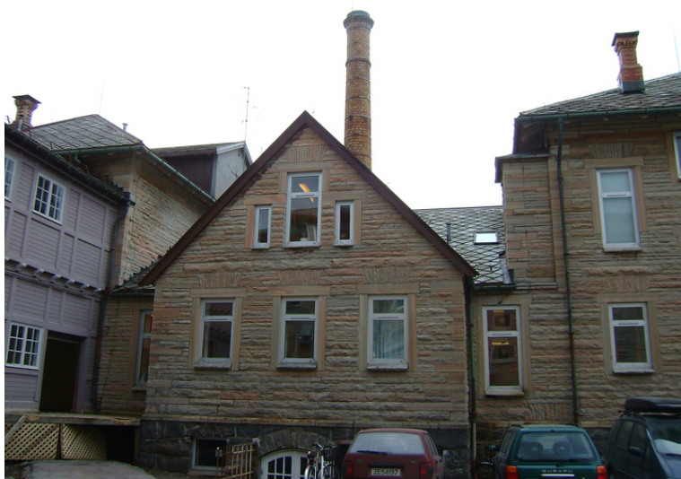
Foto: Leif Maliks, Forsvarsbygg.
