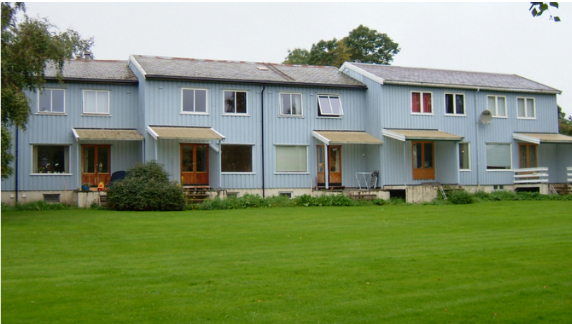
Sørfasadene sett fra vest. Foto: Leif Maliks, Forsvarsbygg.
