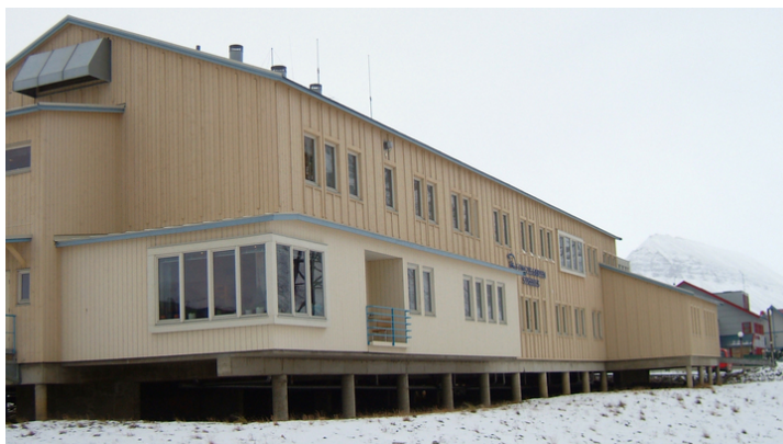
Bygningen sett fra nord. Foto: Leif Maliks, Forsvarsbygg.
