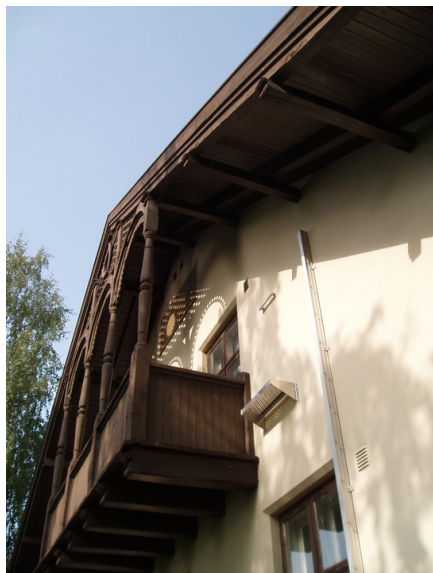
Veranda på gavl mot sør. Foto: Leif Anker, Forsvarsbygg.
