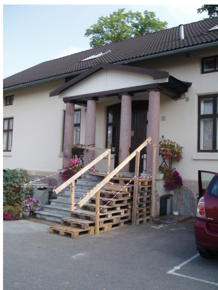
Inngangspartiet i 2006. Foto: Leif Anker, Forsvarsbygg.
