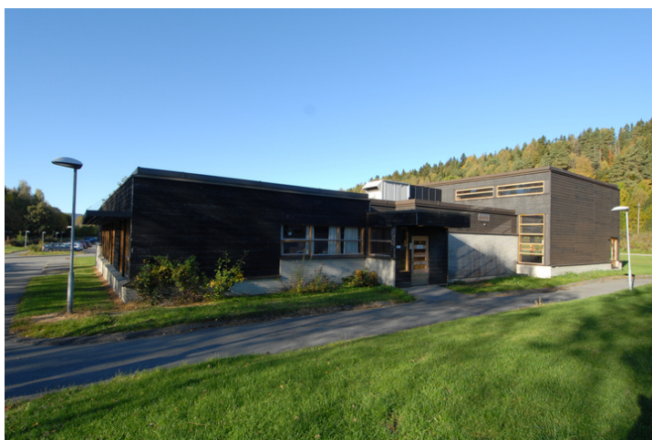
Skolebygget fra øst. Foto: Leif Anker, Forsvarsbygg.
