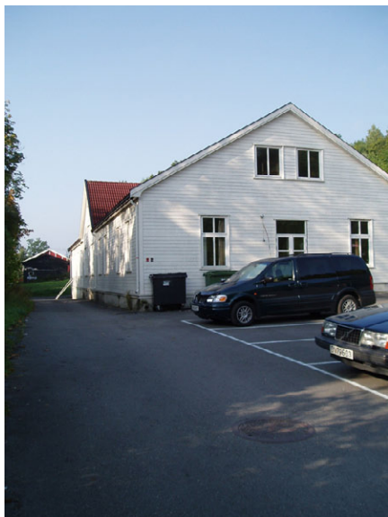
Bygning I fra øst. Foto: Leif Anker, Forsvarsbygg.
