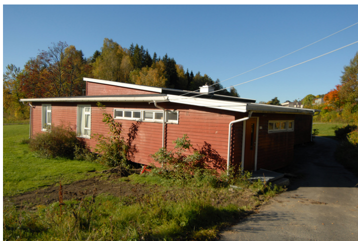
Fasde mot øst og nord. Foto: Leif Anker, Forsvarsbygg.
