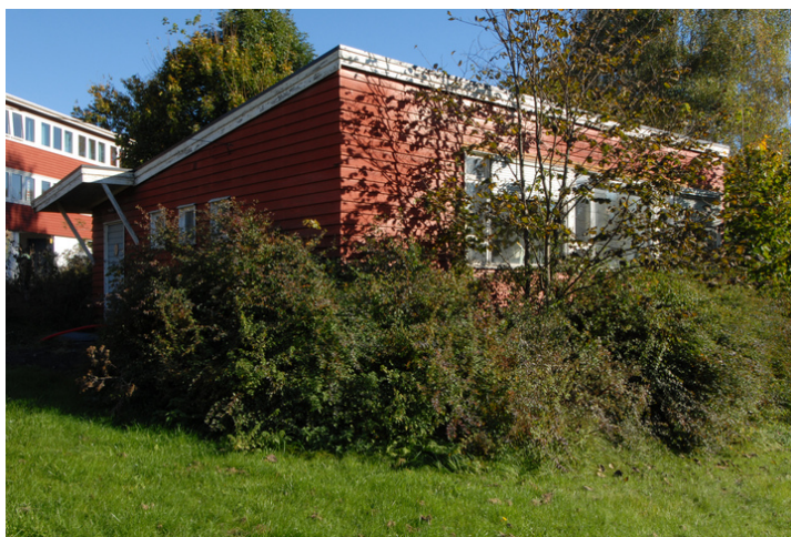
Fasade mot sørøst. Foto: Leif Anker, Forsvarsbygg.
