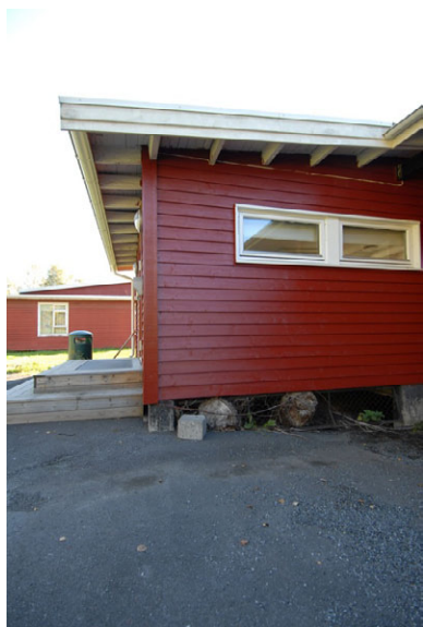
Inngangsparti og fundamenter. Foto: Leif Anker, Forsvarsbygg.
