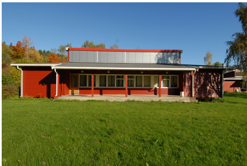
Fasade fra sør. Foto: Leif Anker, Forsvarsbygg.
