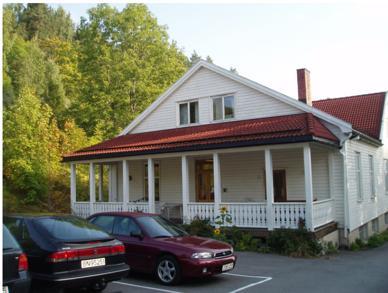
Bygning II sett far vest. Foto: Leif Anker, Forsvarsbygg.
