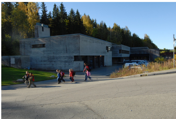
Teknisk sentral og kjøkkenbygg. Foto: Leif Anker, Forsvarsbygg.
