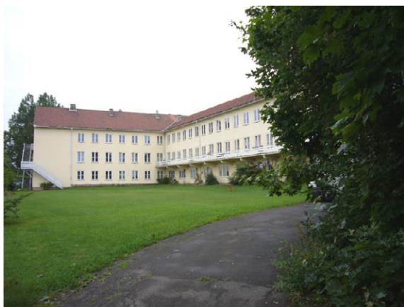
Bygningen sett fra sør. Foto: A. Johnsen, AUS HF.
