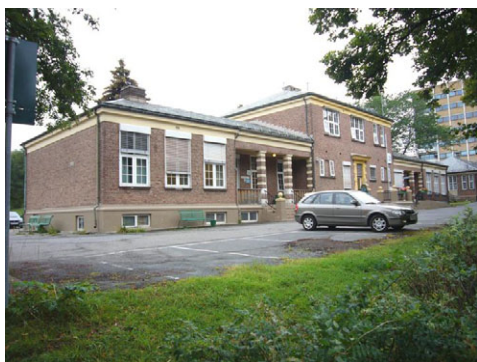
Bygningen sett fra nordvest. Foto: A. Johnsen, AUS.
