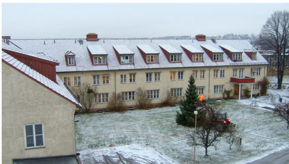
Administrasjonsbygget fra øst Foto: Leif Maliks, Forsvarsbygg.
