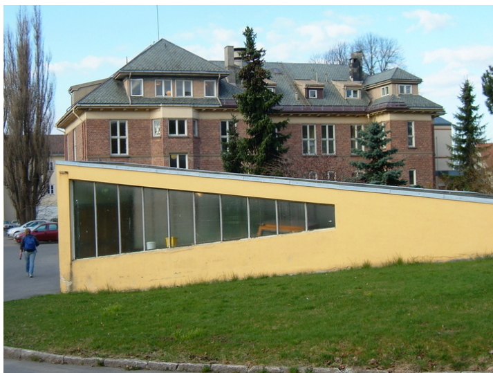
Kulvert og tidl tuberkulosebygning Foto: Leif Maliks, Forsvarsbygg.
