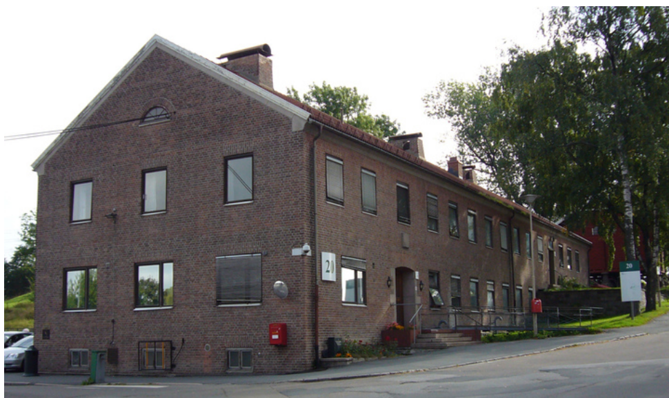
Fasade mot Trondheimsveien Foto: A. Johnsen, AUS.
