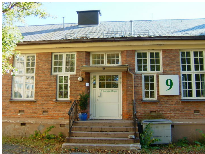
Inngangsparti Foto: Leif Maliks, Forsvarsbygg.
