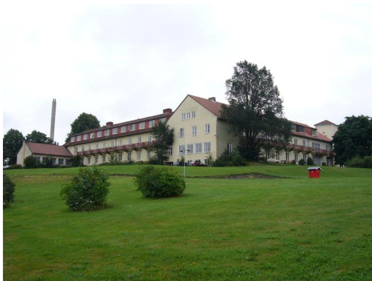
Administrasjonsbygget. Foto: A. Johnsen, AUS.
