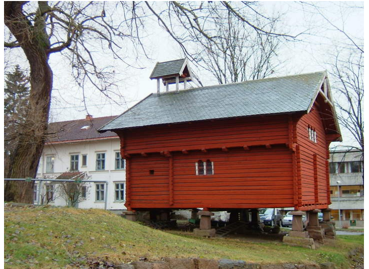
Stabburet sett fra siden Foto: Leif Maliks, Forsvarsbygg.
