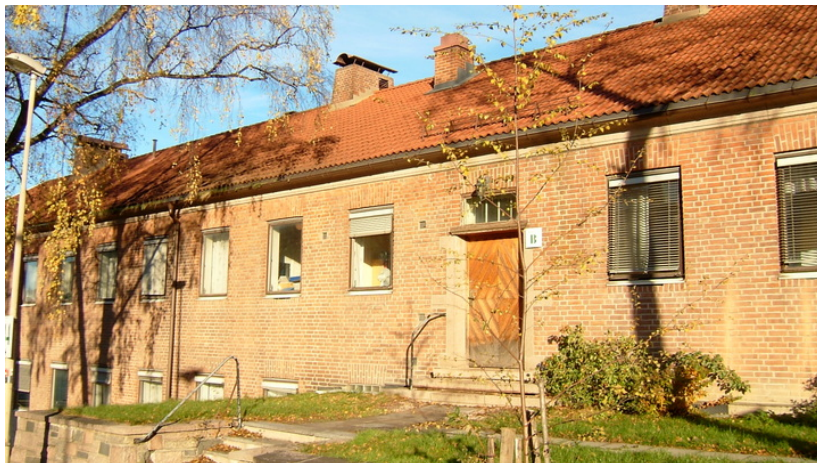
Vestfasade Foto: Leif Maliks, Forsvarsbygg.
