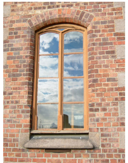
Eldre vindu Foto: Leif Maliks, Forsvarsbygg.
