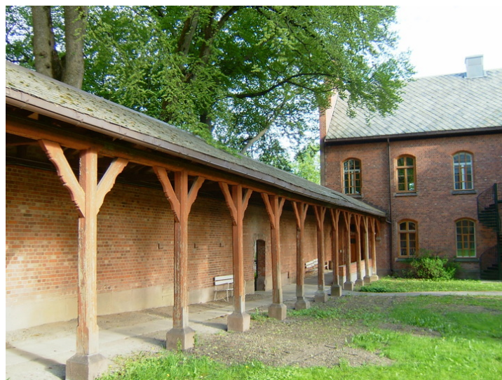
Ovredekket gang Foto: Leif Maliks, Forsvarsbygg.
