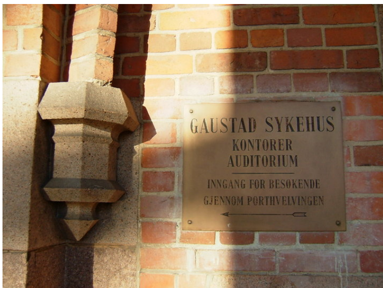
Detalj fra inngang Foto: Leif Maliks, Forsvarsbygg.
