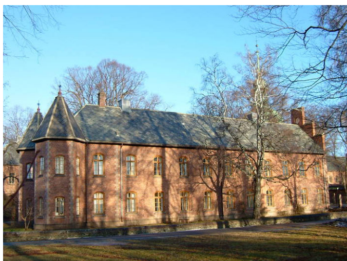
Fasade mot syd Foto: Leif Maliks, Forsvarsbygg.
