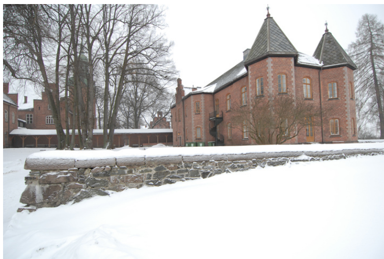
Fasade fra nordvest Foto: Leif Anker, Forsvarsbygg.
