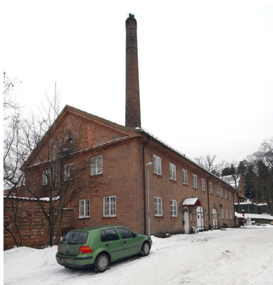
Bygg G09, fyrhus, sett fra sørøst. Foto: Leif Anker, Forsvarsbygg.
