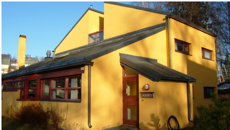
Overgangsbolig, fra vest. Foto: Leif Maliks, Forsvarsbygg.
