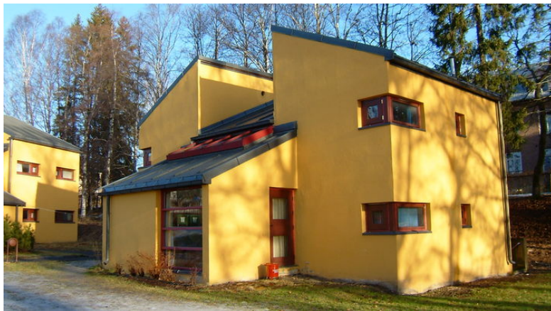
Overgangsboligen fra vest. Foto: Leif Maliks, Forsvarsbygg.
