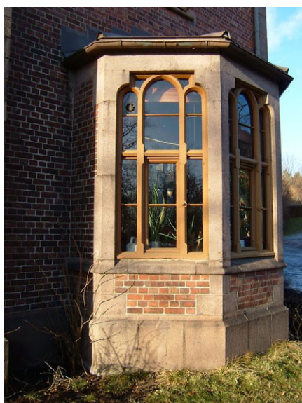
Karnapp Foto: Leif Maliks, Forsvarsbygg.
