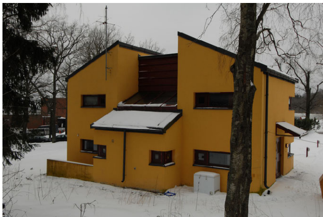
Bolig, bygg G15, sett fra nord-øst. Foto: Leif Anker, Forsvarsbygg.
