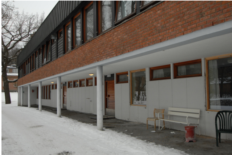
Bygning 21 eksteriør fra SV. Foto: Leif Anker, Forsvarsbygg.
