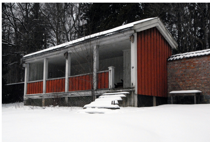
Liggeskur utenfor bygg G20, sett fra øst. Foto: Leif Anker, Forsvarsbygg.
