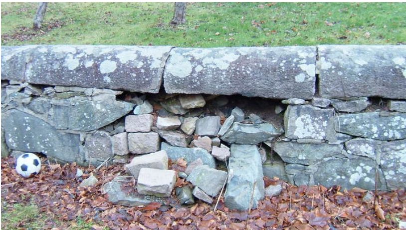
Foto: Leif Maliks, Forsvarsbygg.
