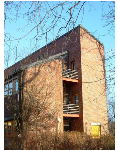
Kortsiden mot syd. Foto: Leif Maliks, Forsvarsbygg.
