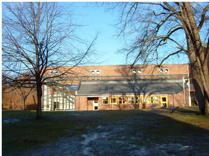
Østfløyen mot syd. Foto: Leif Maliks, Forsvarsbygg.
