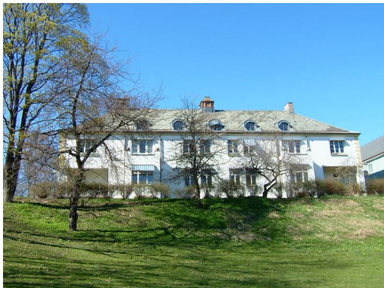
Fasaden mot sør-sørøst. Foto: Lei Maliks, Forsvarsbygg.
