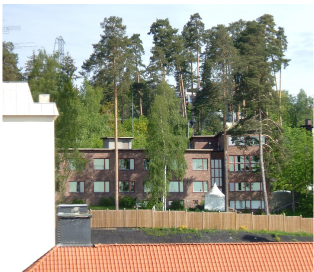
Sydfasaden sett fra radiumhospitalet. Foto: Leif Maliks, Forsvarsbygg.
