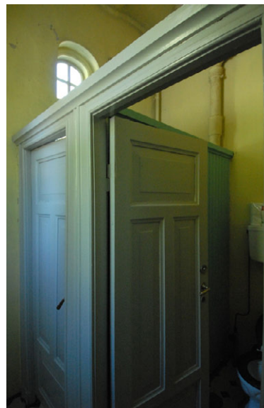
Toalettet. Foto: Leif Anker, Forsvarsbygg.
