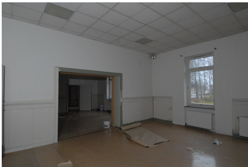
Stue mot vest 2. etasje Foto: Leif Anker, Forsvarsbygg.
