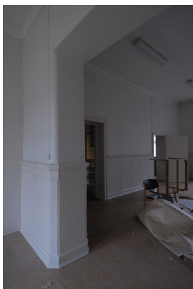
Stuer 1. etasje. Foto: Leif Anker, Forsvarsbygg.
