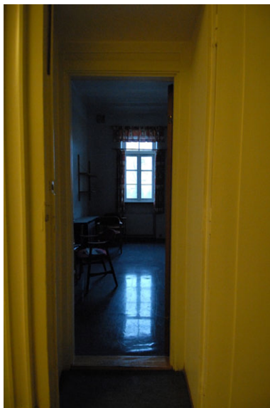
Isolat 1. etasje. Foto: Leif Anker, Forsvarsbygg.
