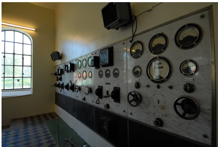
Hovedtavle, maskinhall. Foto: Leif Anker, Forsvarsbygg.
