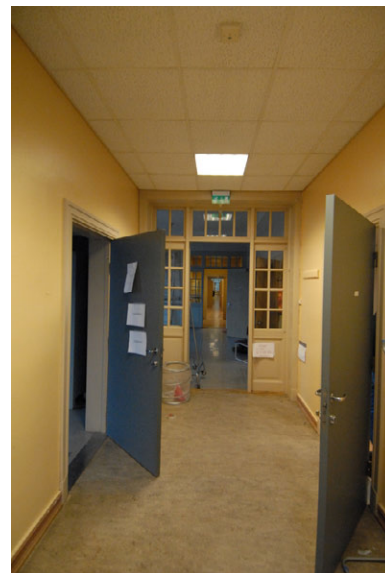
Korridor 2. etg. øst mot hall. Foto: Leif Anker, Forsvarsbygg.
