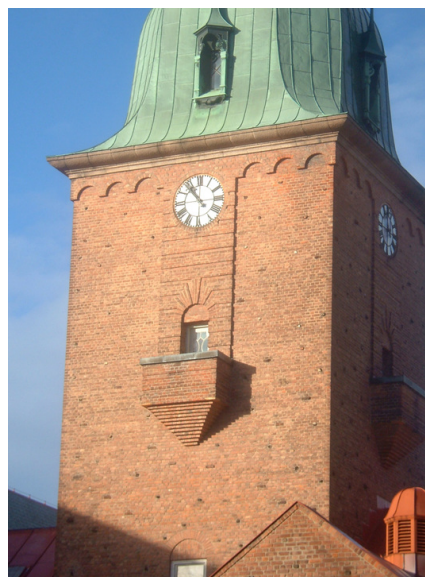
Klokketårnet. Foto: Leif Maliks, Forsvarsbygg.
