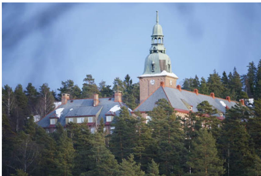
Anlegget sett fra sørvest. Foto: Fra UUSs nettsider.
