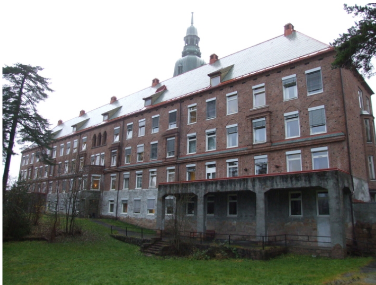
Fasade mot sør. Foto: Leif Anker, Forsvarsbygg.
