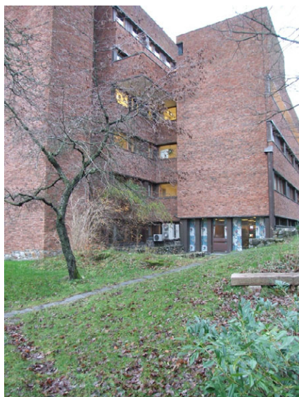
A-fløy mot sørøst. Foto: Leif Anker, Forsvarsbygg.
