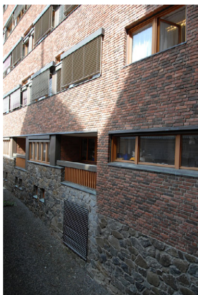
Fasade mot vest, detalj sokkel. Foto: Leif Anker, Forsvarsbygg.
