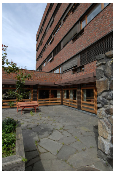
Atrium /terrasse C-fløy. Foto: Leif Anker, Forsvarsbygg.
