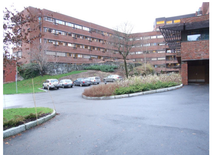
C-fløy t.v., østfasade. Foto: Leif Anker, Forsvarsbygg.
