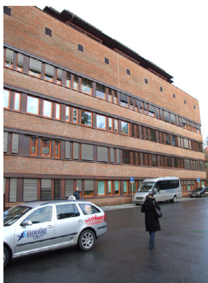
E-fløy mot sør og hovedinngangen. Foto: Leif Anker, Forsvarsbygg.
