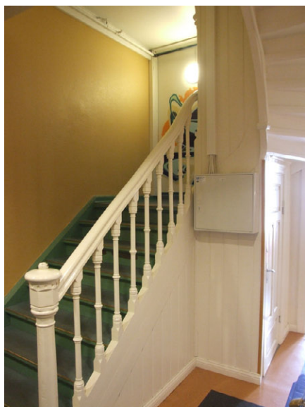
Trapp sør-øst. Foto: Leif Anker, Forsvarsbygg.
