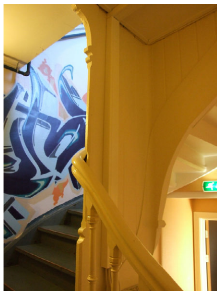
Trappehus sør-øst. Foto: Leif Anker, Forsvarsbygg.
