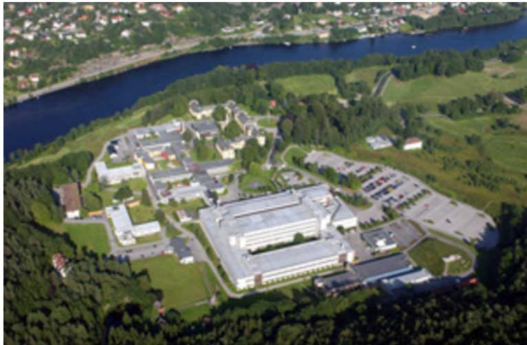
Flyfoto der anlegget sees mot øst. Foto: Sørlandet sykehus.
