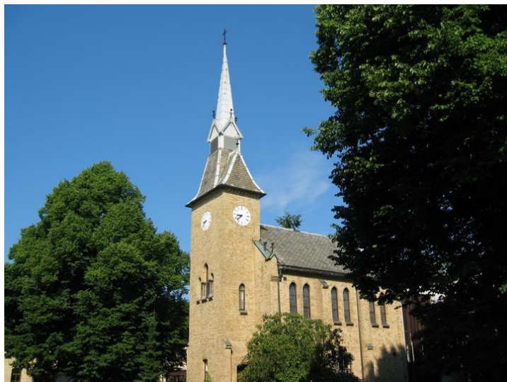
Fasade mot øst og sør. Foto: Tor Andersen.
