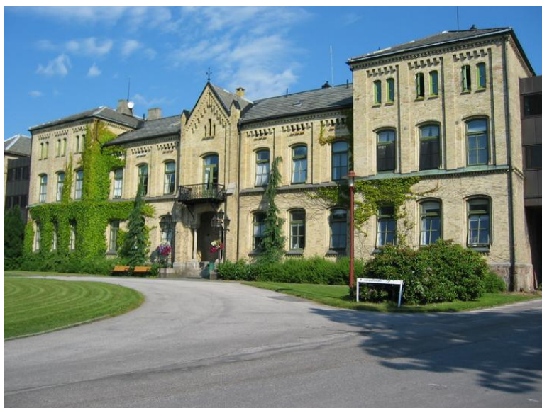
Fasade mot sør Foto: Tor Andersen
