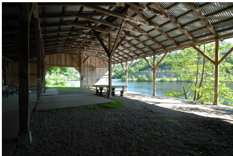
Båthuset innvendig, utsikt fra sør mot nord. Foto: Leif Anker, Forsvarsbygg.
