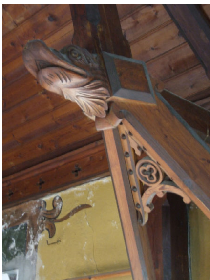
Detalj, takkonstruksjon. Foto: Leif Anker, Forsvarsbygg.
