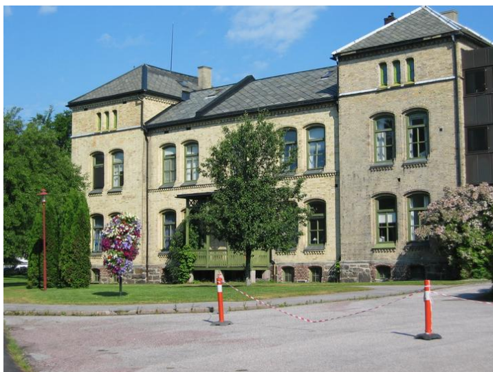
Fasade mot sør. Foto: Tor Andersen.
