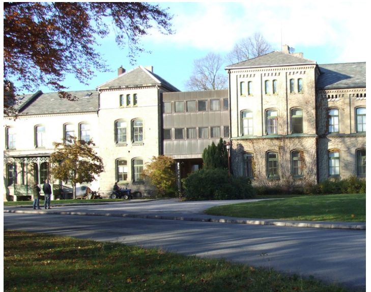
Det vestligste mellombygget (i midten) sett fra sør. Foto: Leif Anker, Forsvarsbygg.
