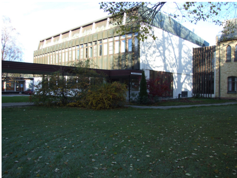
Vest- og sørfasaden. Foto: Leif Anker, Forsvarsbygg.
