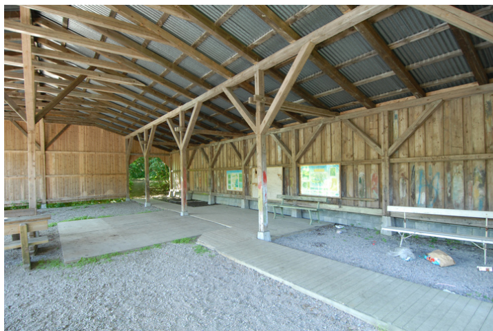
Innvendig, mot sørvest. Foto: Leif Anker, Forsvarsbygg.
