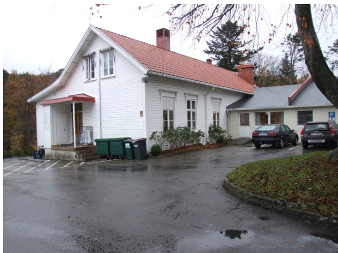
Det gamle hovedbygget sett fra s.v. Foto: Leif Anker, Forsvarsbygg.
