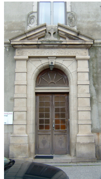
Gamle hovedinngang i St. Josephs gate. Foto: Leif Maliks, Forsvarsbygg.
