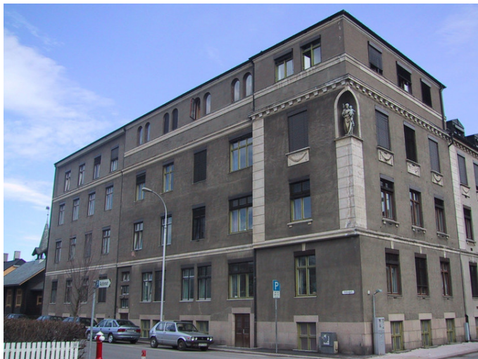
Vestre del av bygningen. Foto: Sykehuset Østfold.
