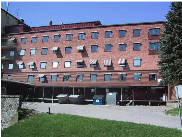
Nordfløyen sett fra øst. Foto: Sykehuset Østfold HF.
