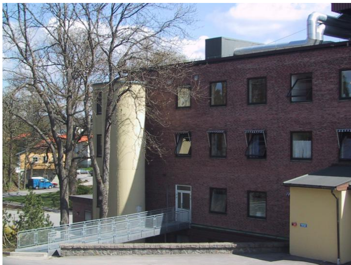
Nordfløyen sett fra vest. Foto: Sykehuset Østfold HF.
