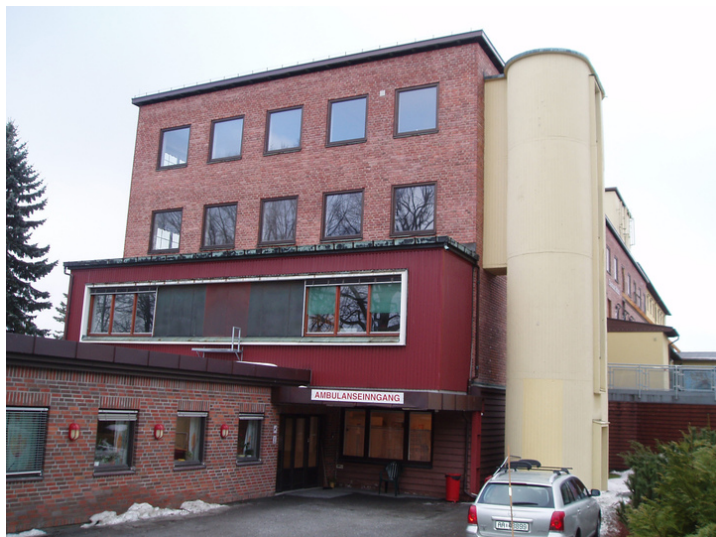
Nordenden av bygningen, med legevakten til venstre. Foto: Ingrid Djupedal, Riksantikvaren.
