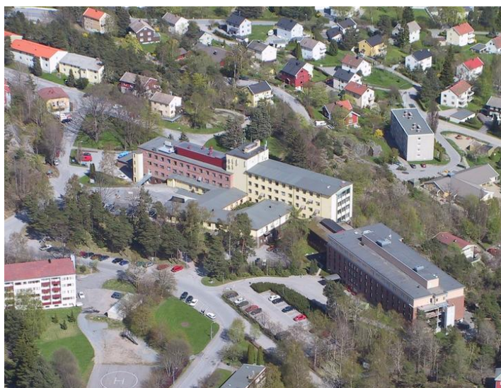
Flyfoto av sykehuset sett fra sørvest. Foto: Sykehuset Østfold.
