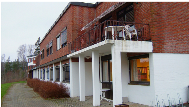
Sørfasaden. Foto: Leif Maliks, Forsvarsbygg.
