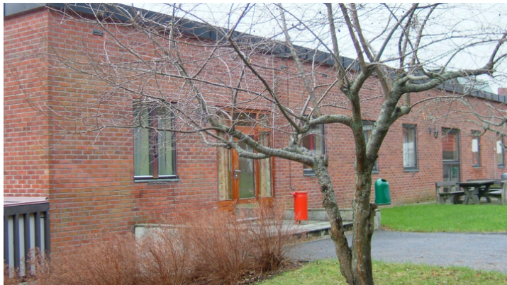
Nordfasaden av bygningen. Foto: Leif Maliks, Forsvarsbygg.
