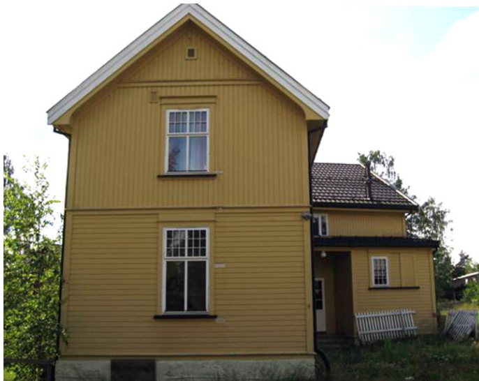
Gavlvegg mot øst. Foto: Solvår Nor Øien.
