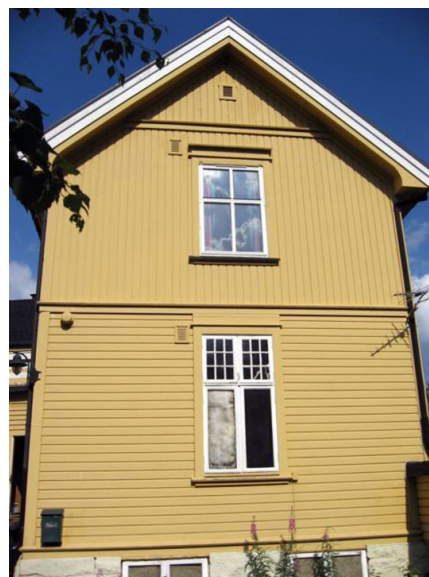
Gavlvegg fra vest. Foto: Solvår Nor Øien.
