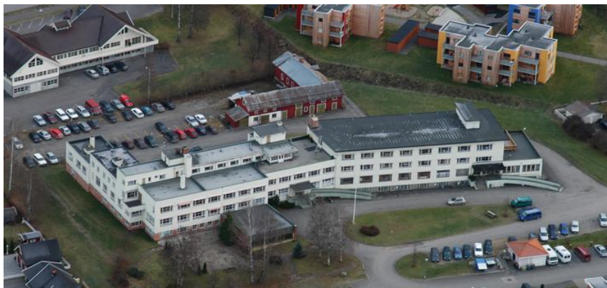
Fysikalsk medisin og rehabilitering Ottestad. Foto: Sykehuset Innlandet HF.
