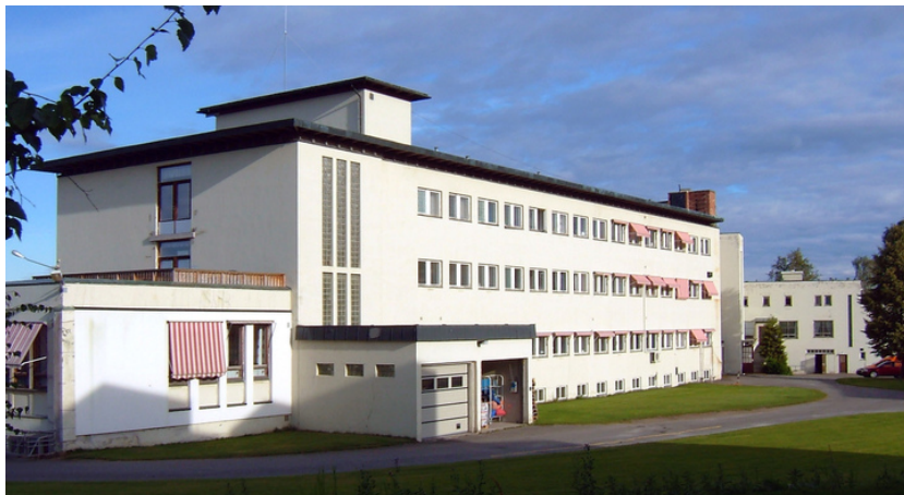
Hovedbygget sett fra sørøst. Foto: Leif Maliks, Forsvarsbygg.
