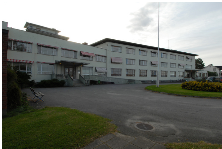
Fasade vest, inngangsparti. Foto: Leif Anker, Forsvarsbygg.
