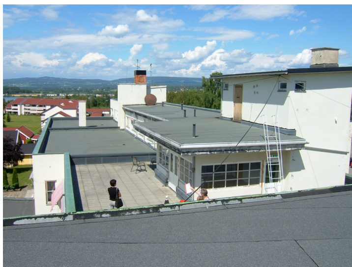
Takterrassen sett fra sør. Foto: Leif Maliks, Forsvarsbygg.
