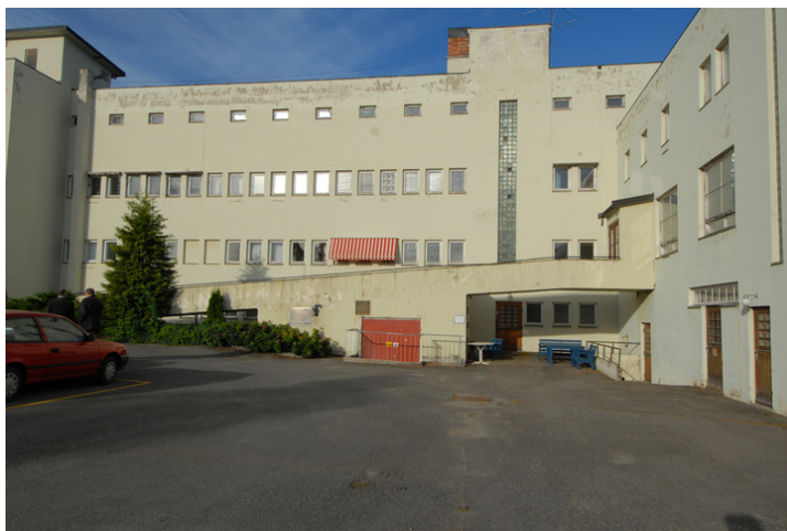
Fasade mot øst og sør. Foto: Leif Anker, Forsvarsbygg.
