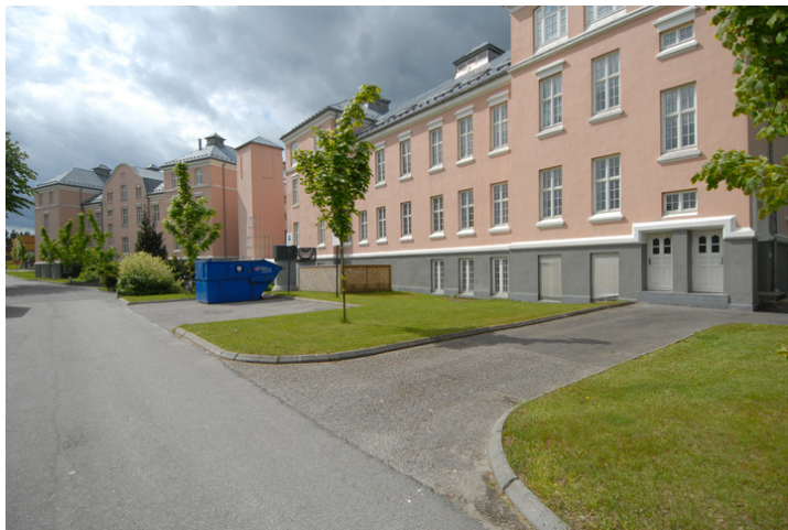
Fasade mot øst. Foto: Leif Anker, Forsvarsbygg.
