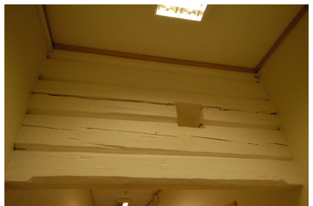
Eldre vegg i korridor B-fløy. Foto: Leif Anker, Forsvarsbygg.
