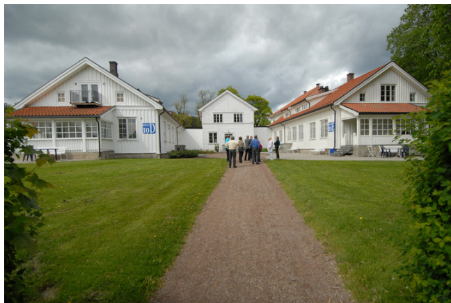
Fasade mot øst. Foto: Leif Anker, Forsvarsbygg.
