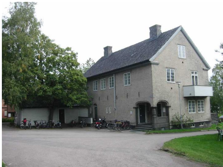
Bygg N, nord-vest.
