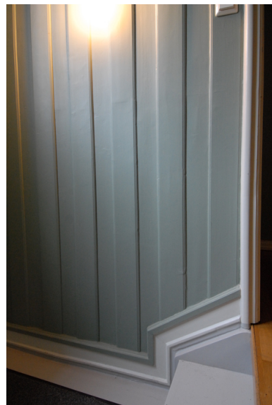
Detalj hovedtrapp. Foto: Leif Anker, Forsvarsbygg.
