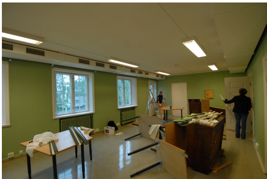
Stue 1. etg. mot sør Foto: Leif Anker, Forsvarsbygg.
