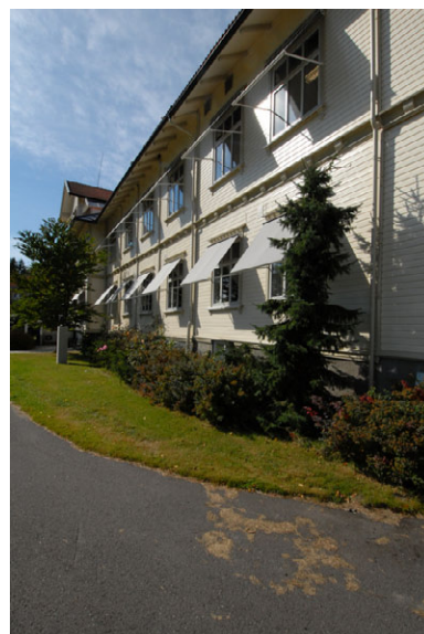
Detalj av hovedfasade mot SØ Foto: Leif Anker, Forsvarsbygg.
