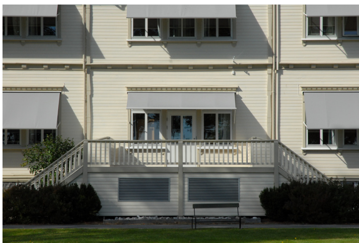
Veranda og trapper hovedfasade Foto: Leif Anker, Forsvarsbygg.
