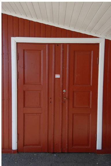
Eldre fyllingsdører gjenbrukt Foto: Leif Anker, Forsvarsbygg.
