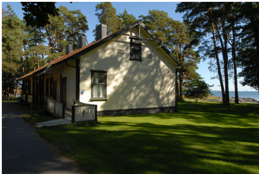
Fasade mot sør Foto: Leif Anker, Forsvarsbygg.
