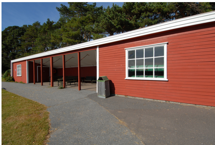
Oppr. kurhall, fasade mot sør Foto: Leif Anker, Forsvarsbygg.
