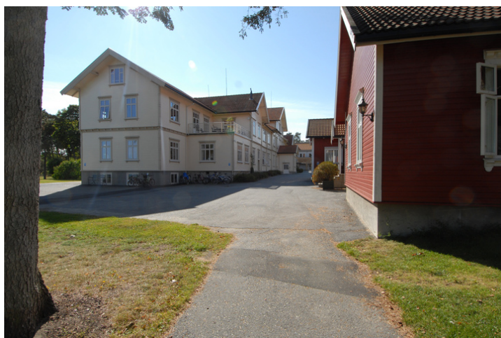
Hovedbygg fra nord Foto: Leif Anker, Forsvarsbygg.
