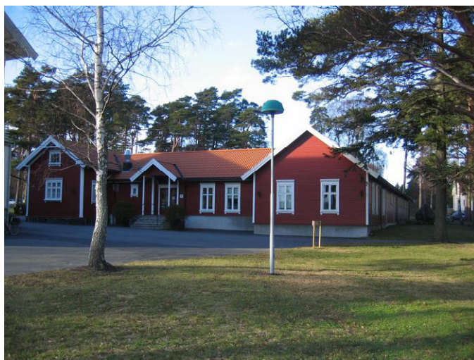
Kysthospitalet - Stallbygning Foto: Kysthospitalet, Stavern
