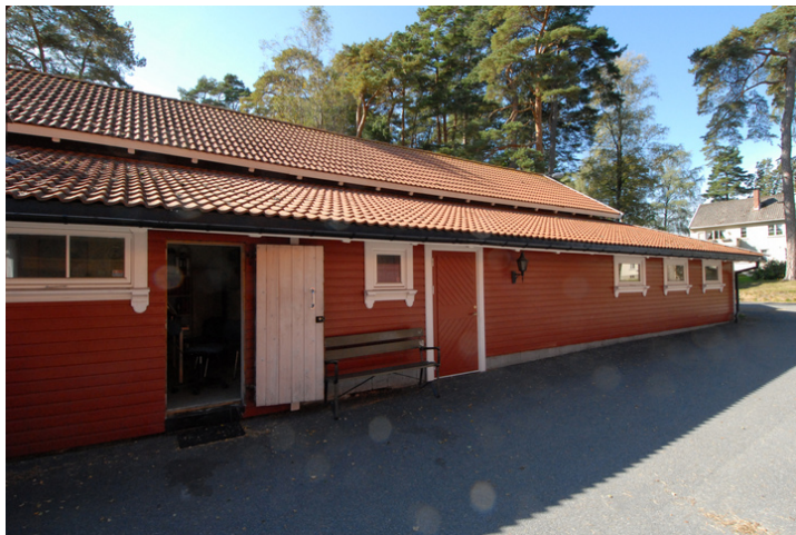
Baksiden av stallbygget Foto: Leif Anker, Forsvarsbygg.
