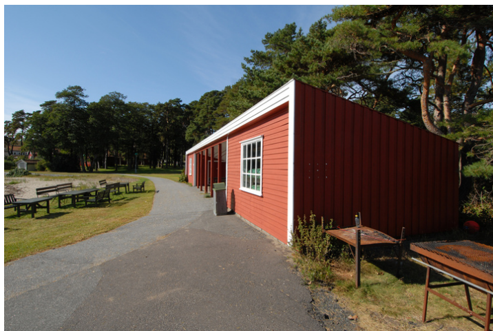
Fasade mot nord Foto: Leif Anker, Forsvarsbygg.
