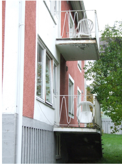
Fasade mot sør Foto: Leif Anker, Forsvarsbygg.
