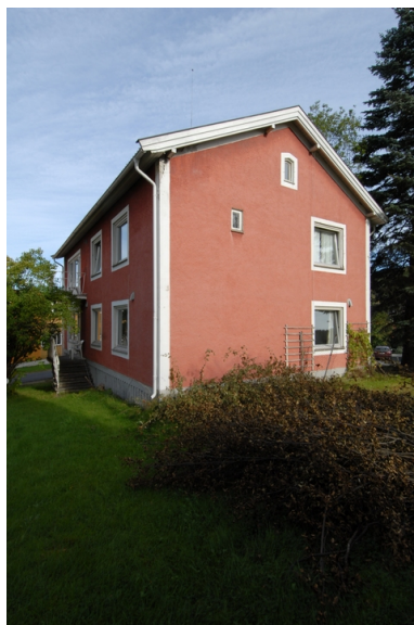
Fasade fra sørøst Foto: Leif Anker, LVPH Forsvarsbygg.
