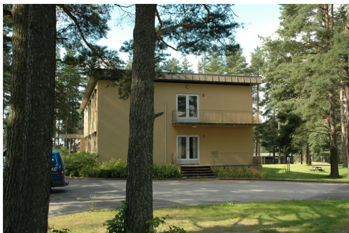
Bygningen sett fra nord. Foto: Marte Oftedal, Forsvarsbygg.
