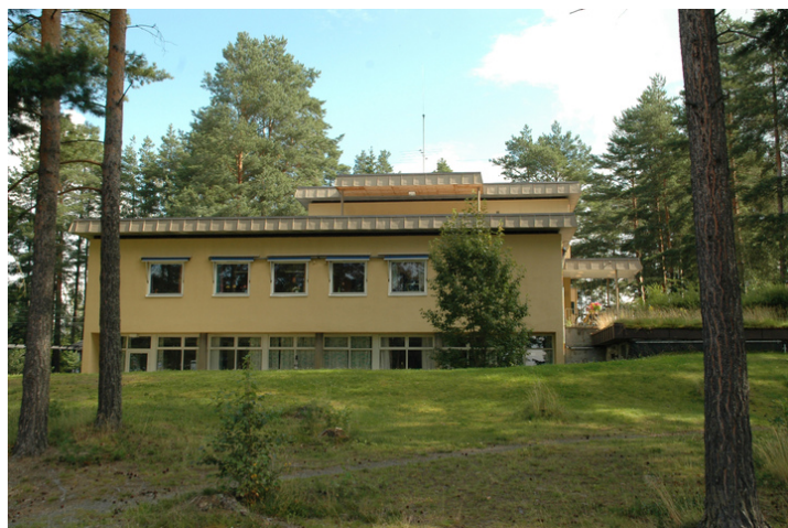
Fasade mot sør. Foto: Marte Oftedal, Forsvarsbygg.
