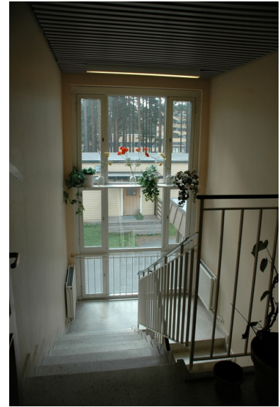
Trappehus mot øst. Foto: Marte Oftedal, Forsvarsbygg.
