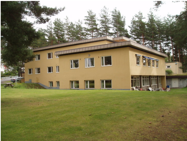
Fasade mot sør og vest Foto: Leif Anker, Forsvarsbygg.
