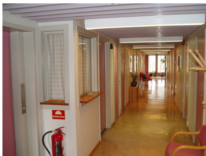
Annen etg. vaktrom og korridor. Foto: Leif Anker, Forsvarsbygg.
