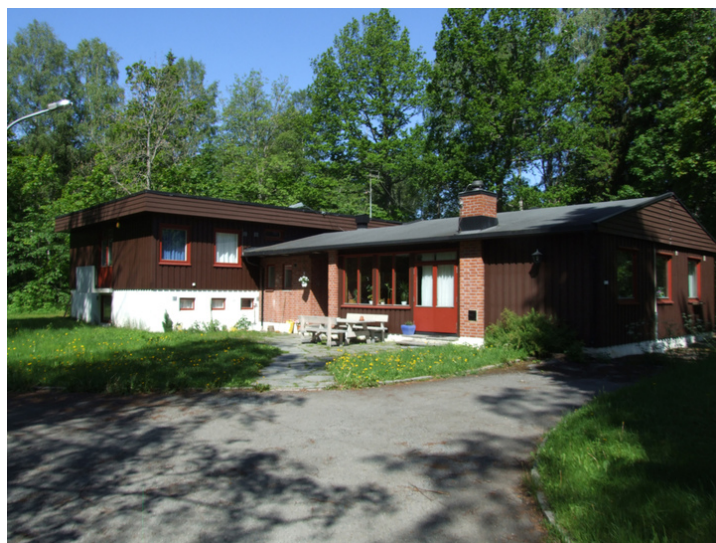
Nyere hybelhus sett fra sør-øst. Foto: Leif Maliks, Forsvarsbygg.
