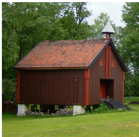
Stabburet sett fra sør-sørøst. Foto: Leif Maliks, Forsvarsbygg.
