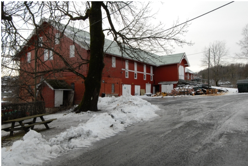
Bygg 14 låve sett fra nordvest. Foto: Leif Anker, Forsvarsbygg.
