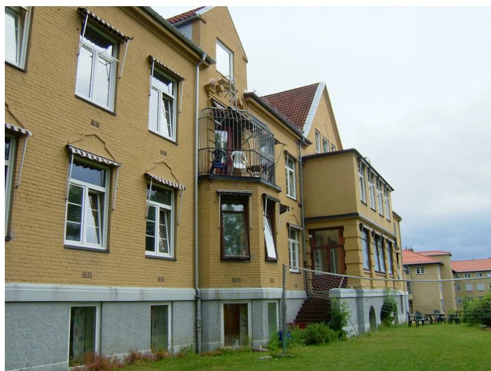
Foto: Leif Maliks, Forsvarsbygg.
