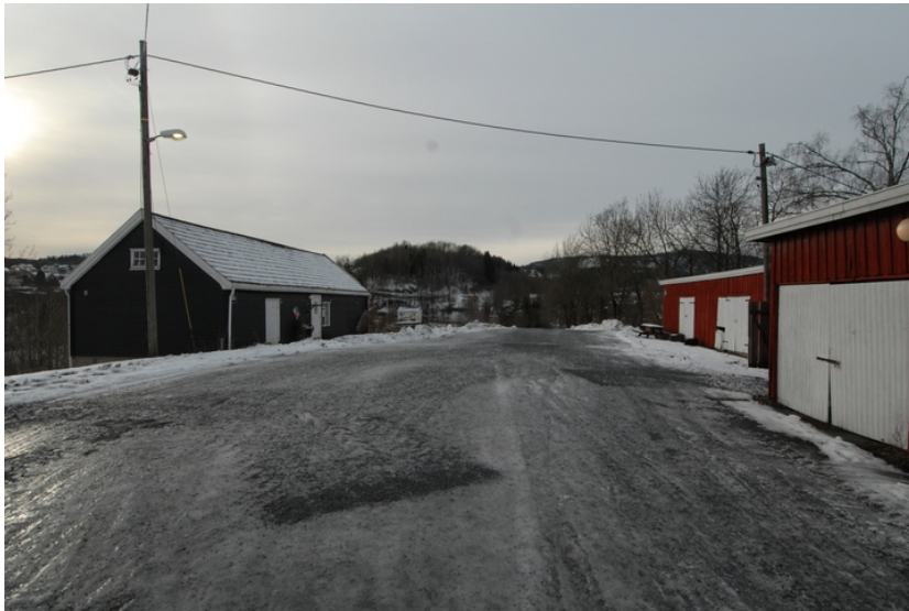
Bygning 16 t.v., sett fra nord. Foto: Leif Anker, Forsvarsbygg.
