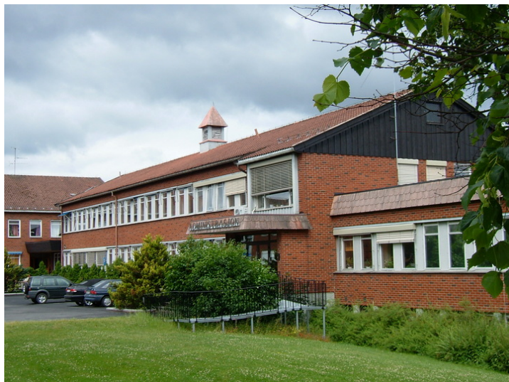
Administrasjonsbygget på Blakstad. Foto: Leif Maliks, Forsvarsbygg.
