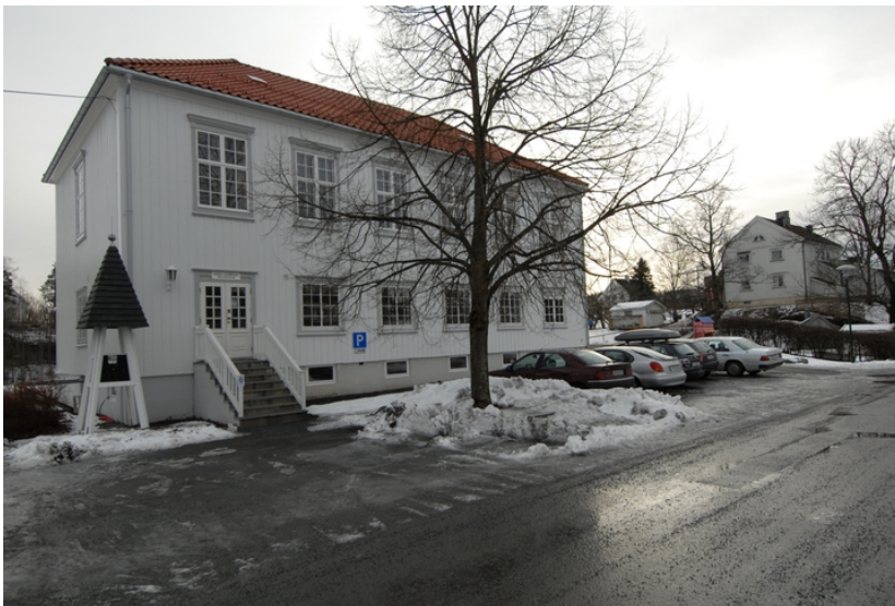
Bygning 5 sett fra vest. Foto: Leif Anker, Forsvarsbygg.
