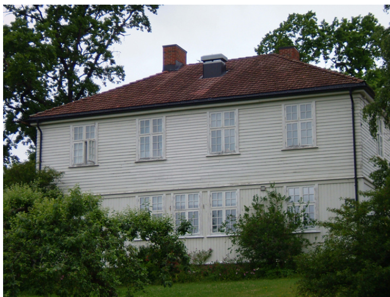
Bygning 24 sett fra øst. Foto: Leif Maliks, Forsvarsbygg. Opphavsrett:
