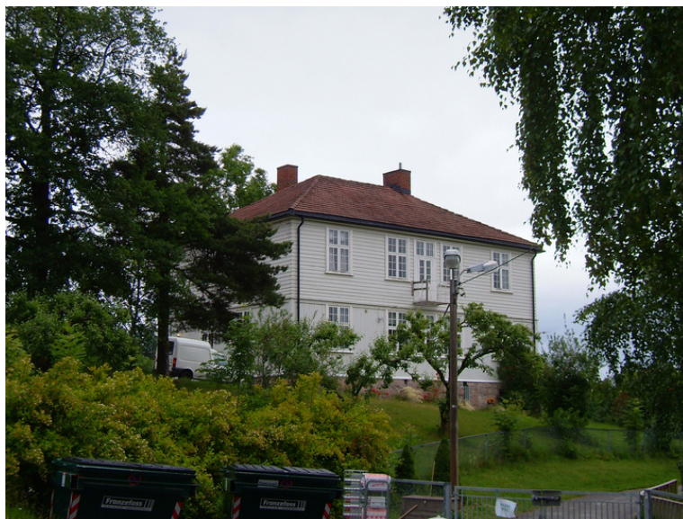
Bygning 23 sett fra øst. Foto: Leif Maliks, Forsvarsbygg. Opphavsrett:
