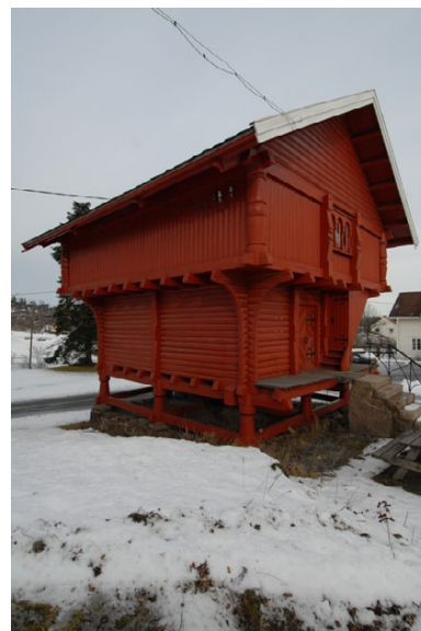
Bygg 18 stabbur sett fra sørøst. Foto: Leif Anker, Forsvarsbygg.
