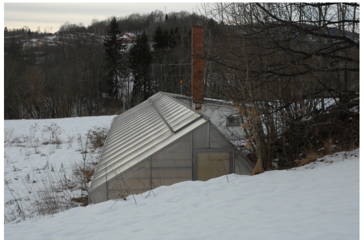
Drivhus og fyrhus. Foto: Leif Anker, Forsvarsbygg.
