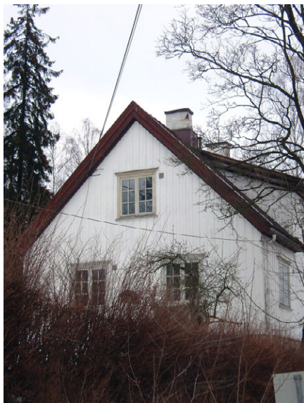
Portnerboligen sett fra sørvest. Foto: Leif Maliks, Forsvarsbygg.
