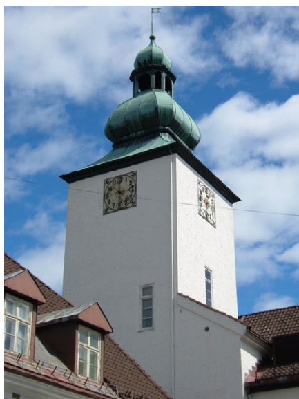
Tårnet på Bærum sykehus,. Foto: Leif Maliks, Forsvarsbygg.
