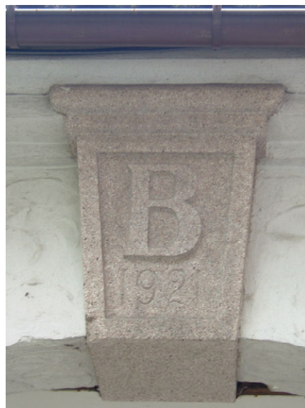
Sluttstein. Foto: Leif Maliks, Forsvarsbygg.
