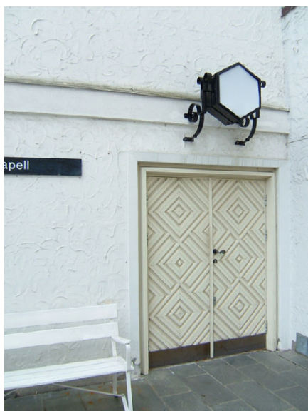
Inngang til kapellet i sydføløyen. Foto: Leif Maliks, Forsvarsbygg.
