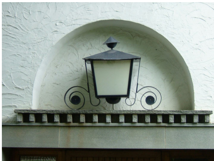
Smijernslykt på sydføløyen. Foto: Leif Maliks, Forsvarsbygg. Opphavsrett:
