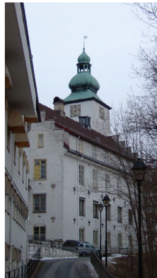
Fasade mot øst. Foto: Leif Maliks, Forsvarsbygg.
