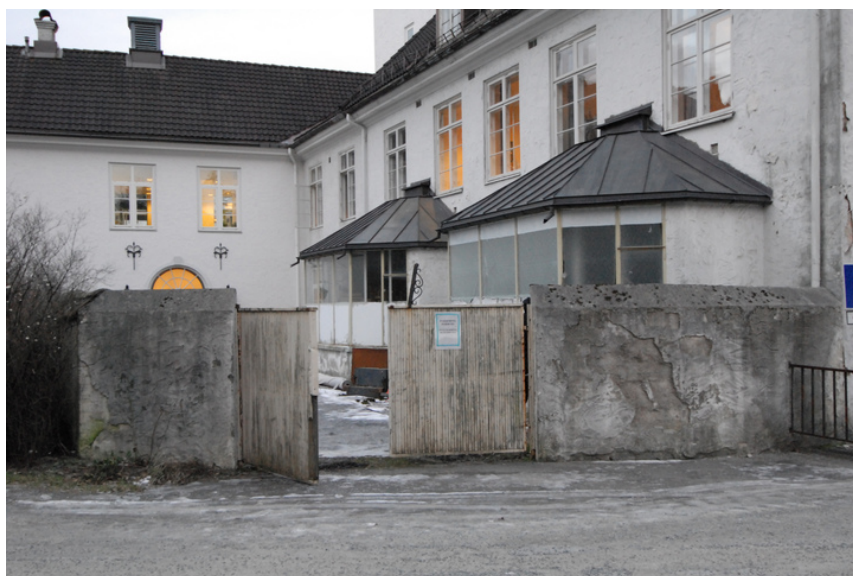
Operasjonssalskarnappene. Foto: Leif Anker, Forsvarsbygg.
