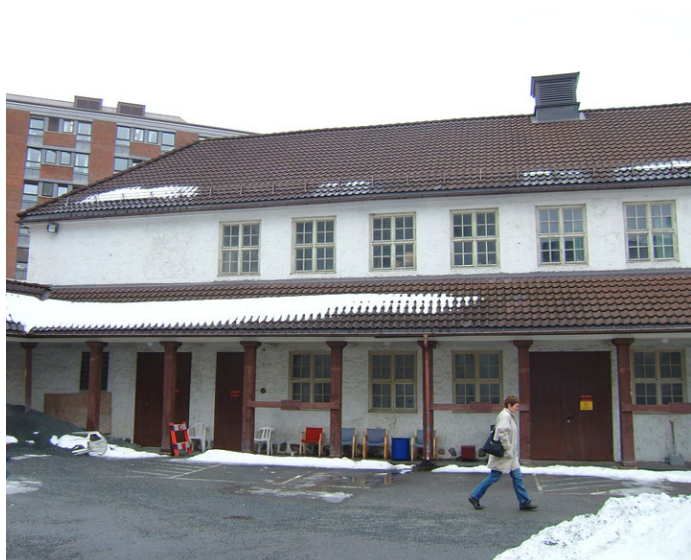
Fyrhuset sett fra gårdsplassen. Foto: Leif Maliks, Forsvarsbygg.
