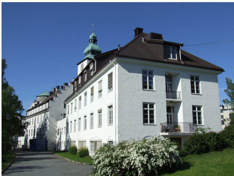
Østfløyen sett fra øst. Foto: Leif Maliks, Forsvarsbygg.
