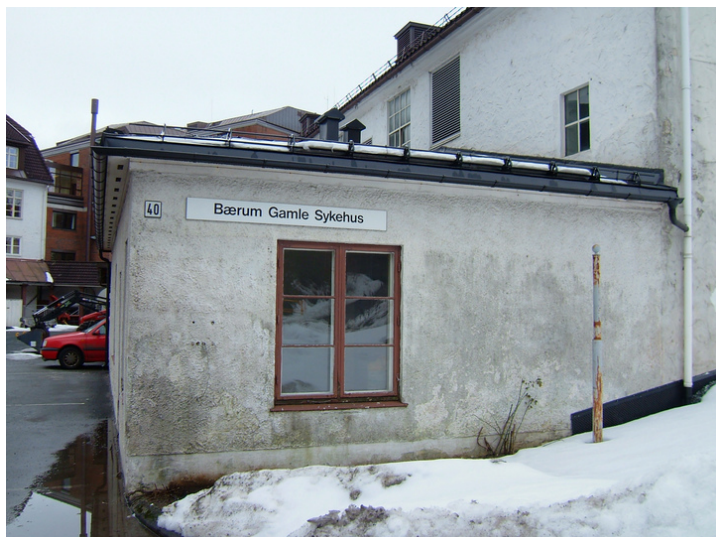
Utbygg østlig del av fyrhuset. Foto: Leif Anker, Forsvarsbygg.
