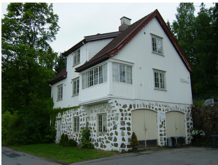
Den gamle portnerboligen og garasjer sett fra øst. Foto: Leif Maliks, Forsvarsbygg.
