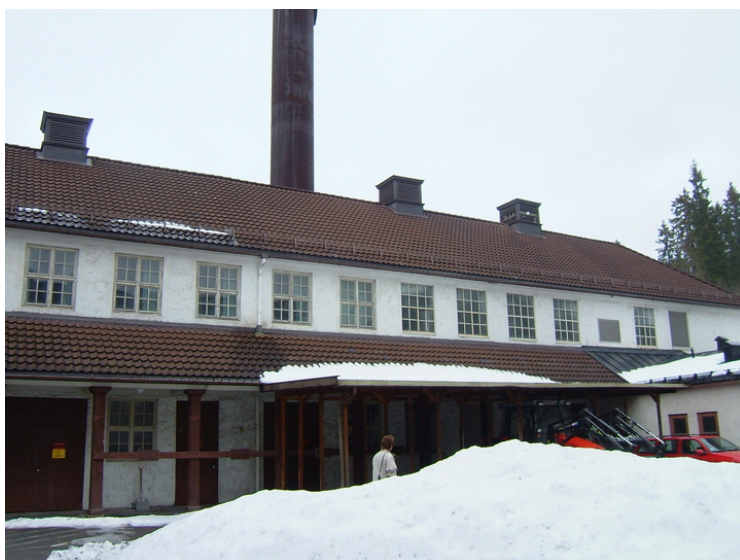
Fyrhuset sett fra "borggården". Foto: Leif Maliks, Forsvarsbygg.
