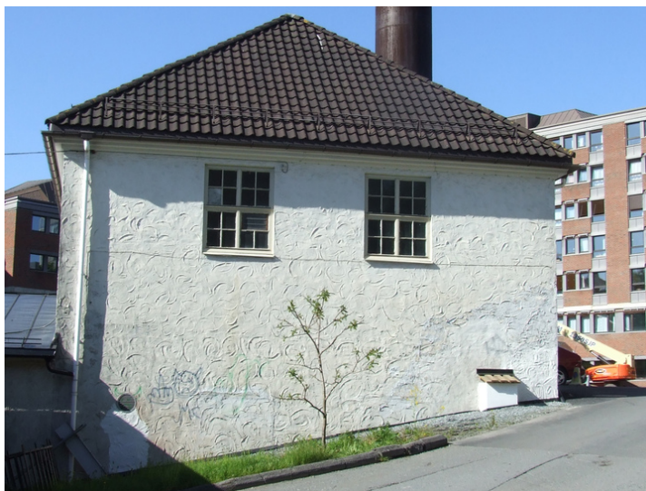
Fyrhuset sett fra nordøst. Foto: Leif Maliks, Forsvarsbygg.
