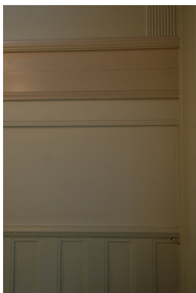
Detalj panel og listverk. Foto: Leif Anker, Forsvarsbygg.
