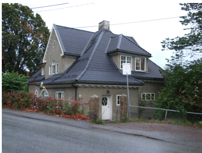
Bergstien 24 sett fra nordvest. Foto: Leif Anker, Forsvarsbygg.
