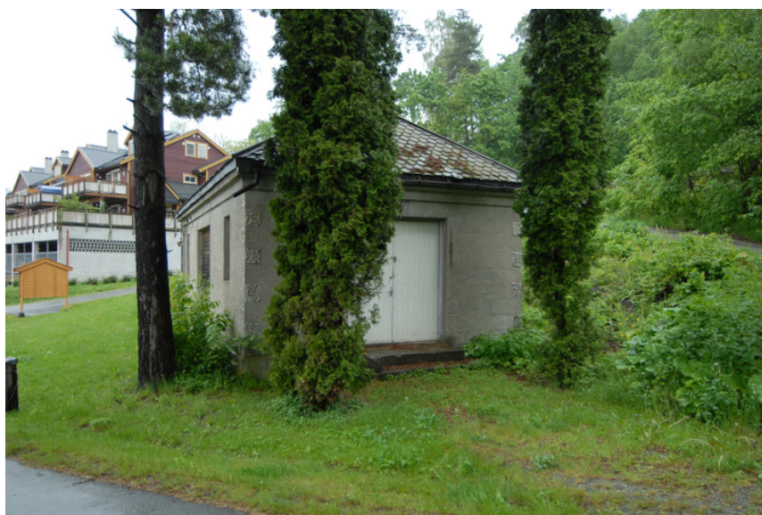
Inngang ligger mot s.ø. Foto: Leif Anker, Forsvarsbygg.
