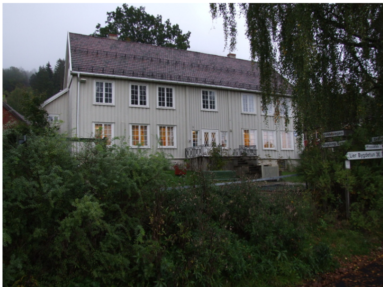
Barnehage i våningshuset, mot s.v. Foto: Leif Anker, Forsvarsbygg.
