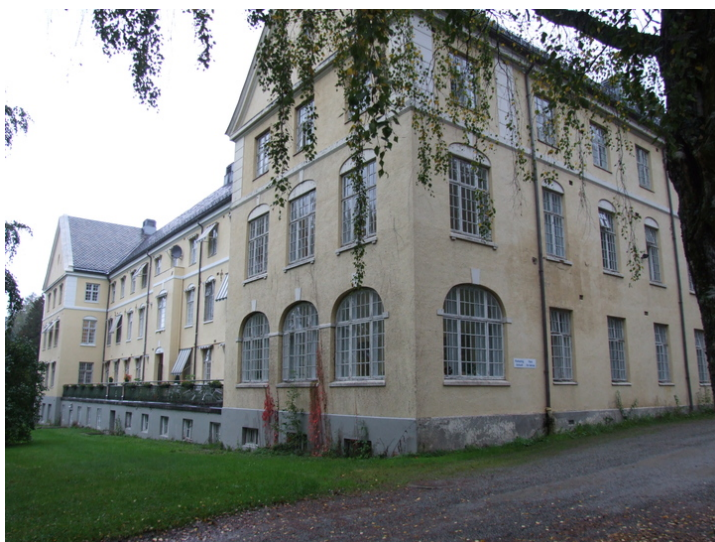
Bygg C fra sørøst. Foto: Leif Anker, Forsvarsbygg.
