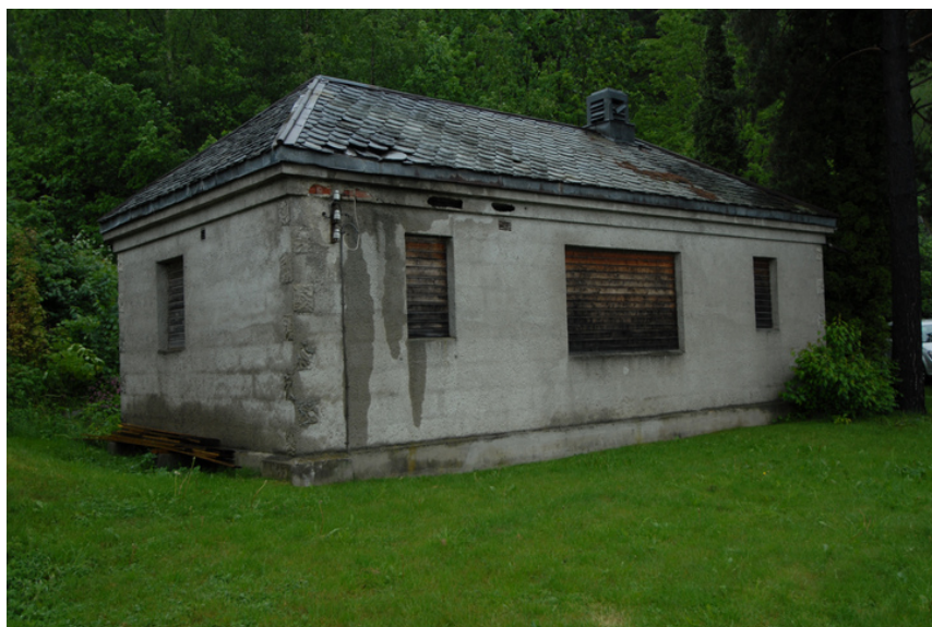
Vinduene er sikret med lemmer. Foto: Leif Anker, Forsvarsbygg.
