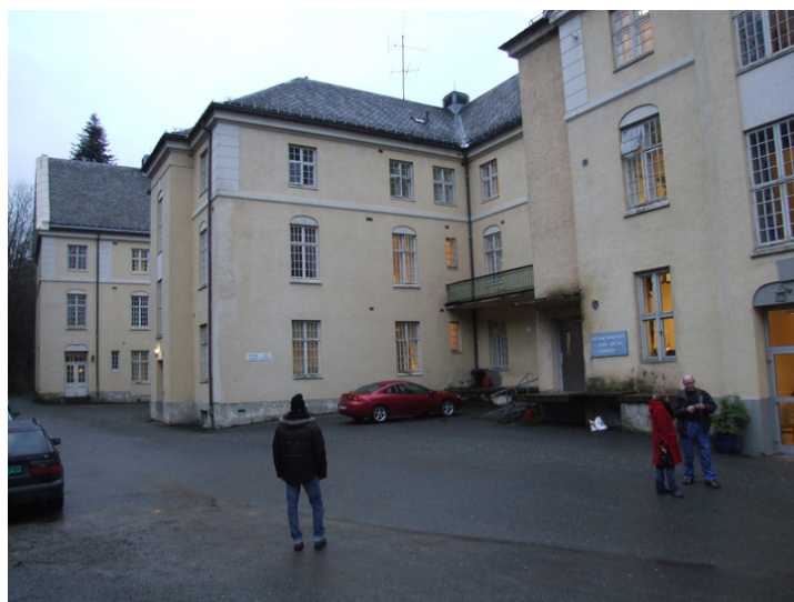
Bygg C fra nordvest. Foto: Leif Anker, Forsvarsbygg.
