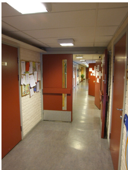
Korridor gjennom anlegget. Foto: Leif Anker, Forsvarsbygg.
