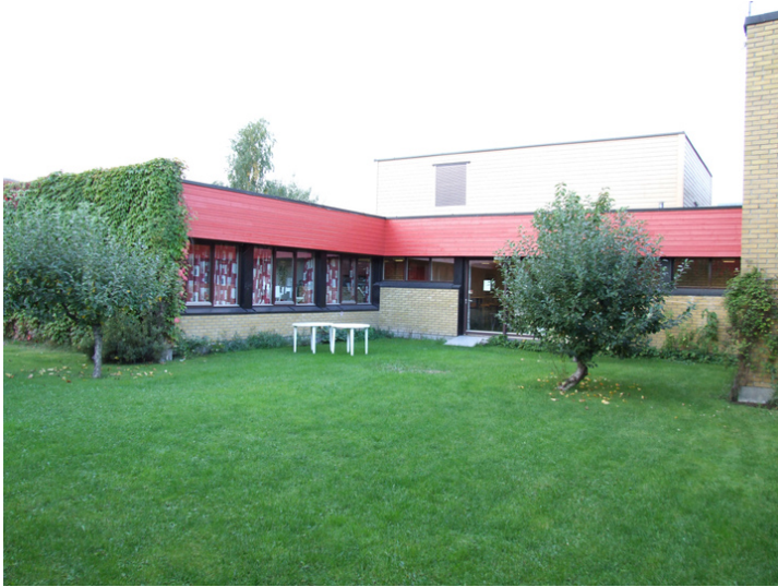
Gårdsrom/atrium mot sørvest. Foto: Leif Anker, Forsvarsbygg.
