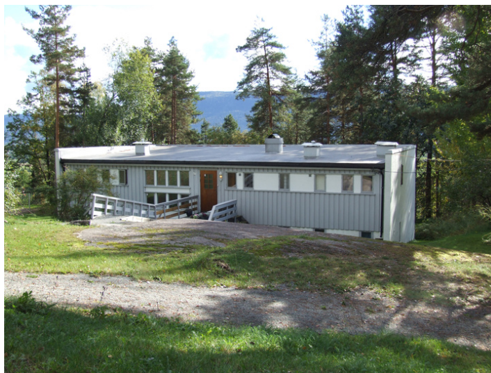
Internatet sett fra nordvest. Foto: Leif Anker, Forsvarsbygg.
