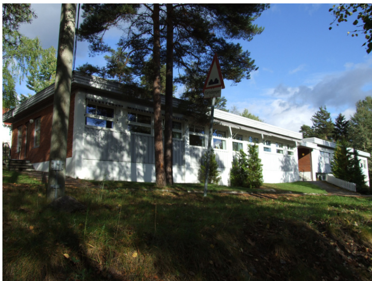
Hovedbygget sett fra sørvest Foto: Leif Anker, Forsvarsbygg.
