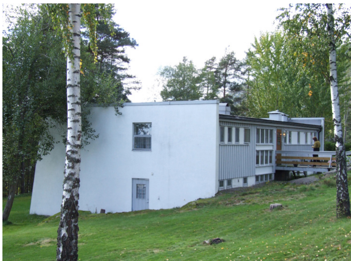
Internatet sett fra nordøst. Foto: Leif Anker, Forsvarsbygg.
