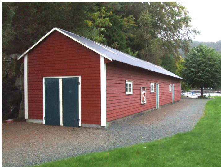
Naustet sett fra sør. Foto: Helse Bergen HF.
