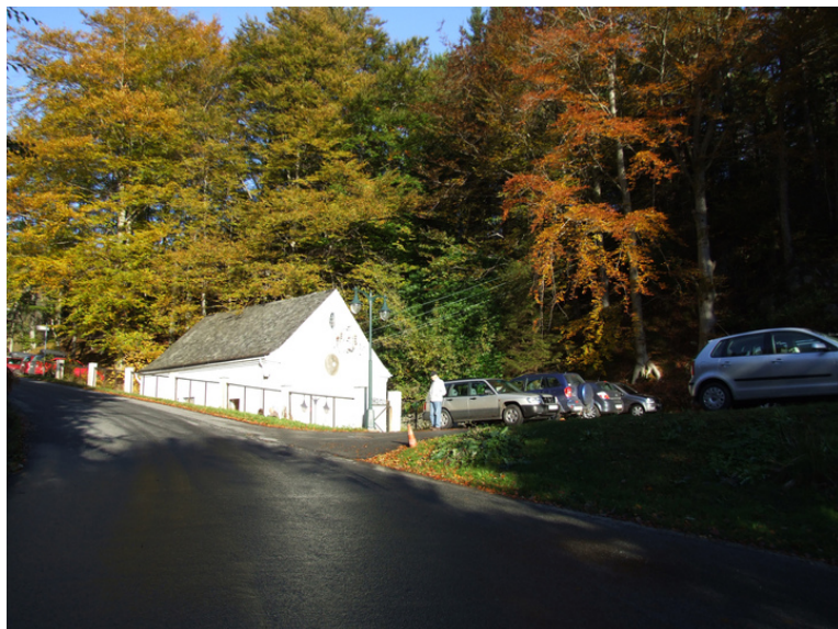
Kraftstasjonen sett fra vest. Foto: Leif Anker, Forsvarsbygg.
