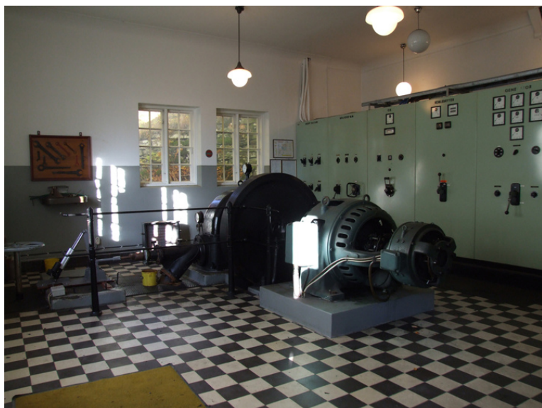
Interiør turbinhall. Foto: Leif Anker, Forsvarsbygg.
