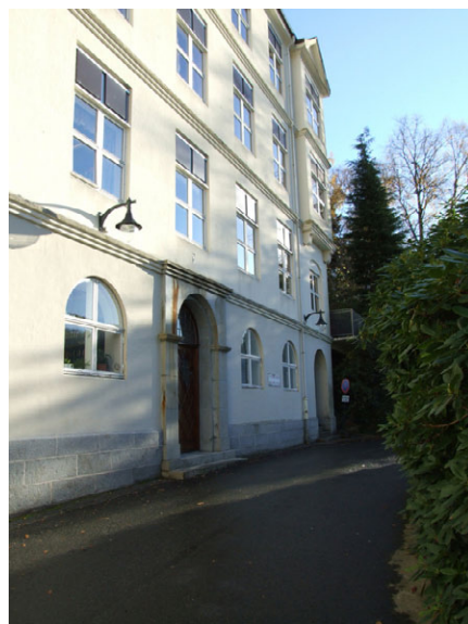
Søfløy med inngangsdør sjøside. Foto: Leif Anker, Forsvarsbygg.
