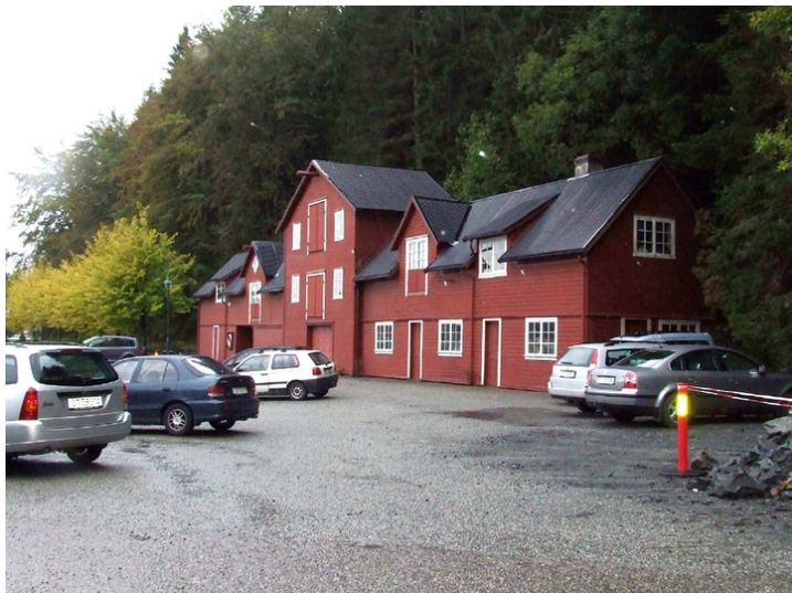
Bygningen sett fra nordvest. Foto: Helse Bergen HF.
