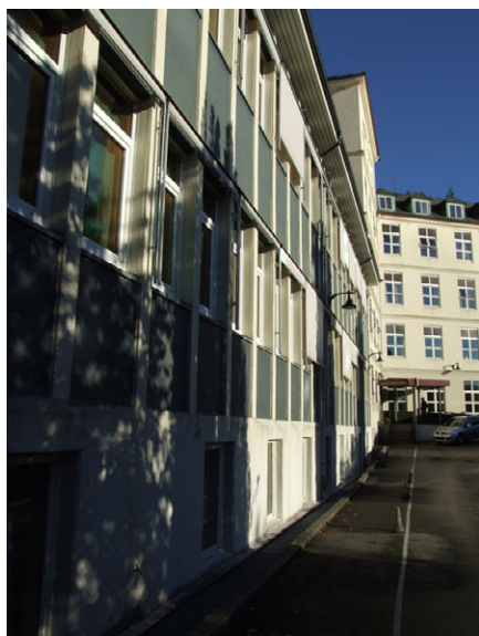
Vestfasade nyeste del (nordfløy). Foto: Leif Anker, Forsvarsbygg.
