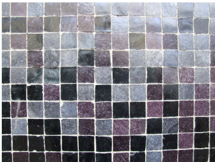
Detalj av fliser fasade 1. etg. Foto: Leif Anker, Forsvarsbygg. Opphavsrett:
