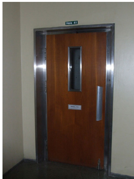
Heisdør 1. etg. Foto: Leif Anker, Forsvarsbygg.
