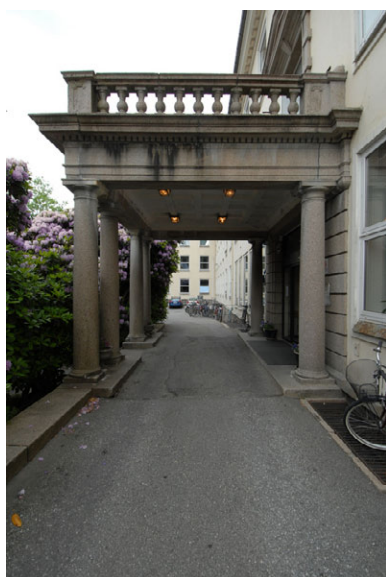
Hovedinngang KK sett fra øst. Foto: Leif Anker, Forsvarsbygg.
