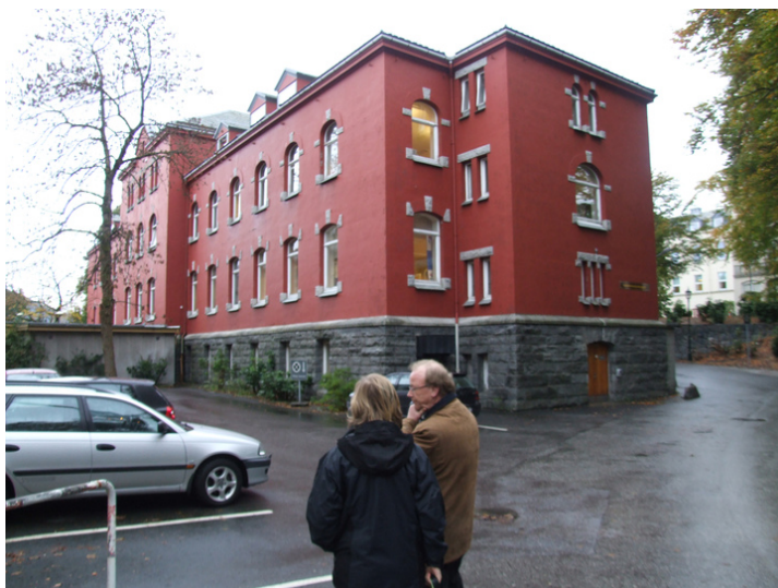
Admin-bygget fra sørøst. Foto: Leif Anker, Forsvarsbygg.
