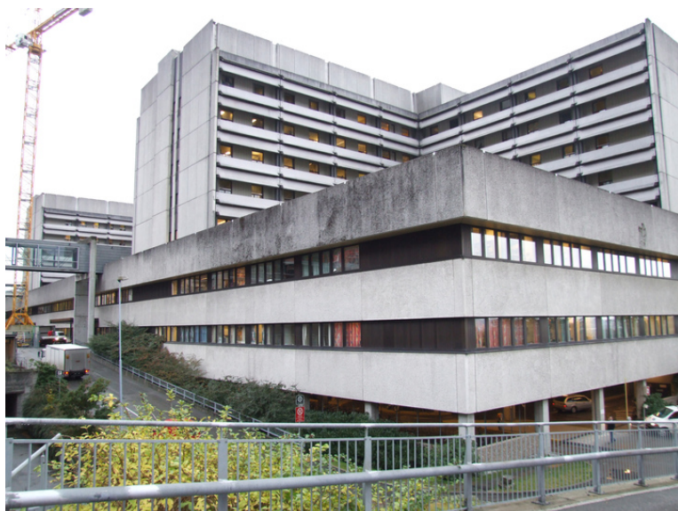
Sentralblokka fra nord Foto: Leif Anker, Forsvarsbygg.
