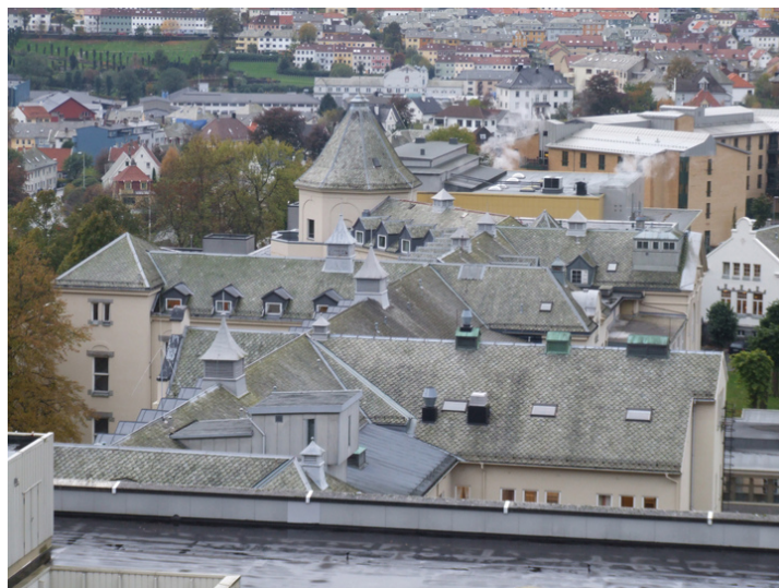
Hovedbygg sett fra sentralblokka. Foto: Leif Anker, Forsvarsbygg.
