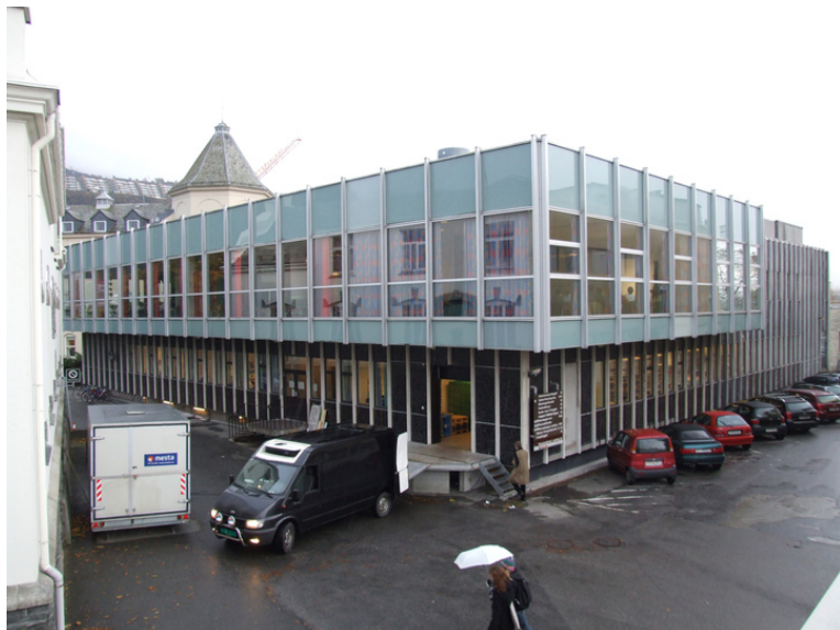
Kantina i 2. etg. markert med glass i fasaden. Foto: Leif Anker, Forsvarsbygg.
