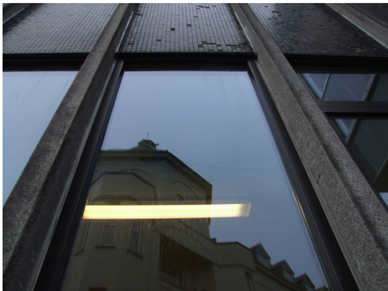
Fasadedetalj med fliser og støpte profiler. Foto: Leif Anker, Forsvarsbygg.
