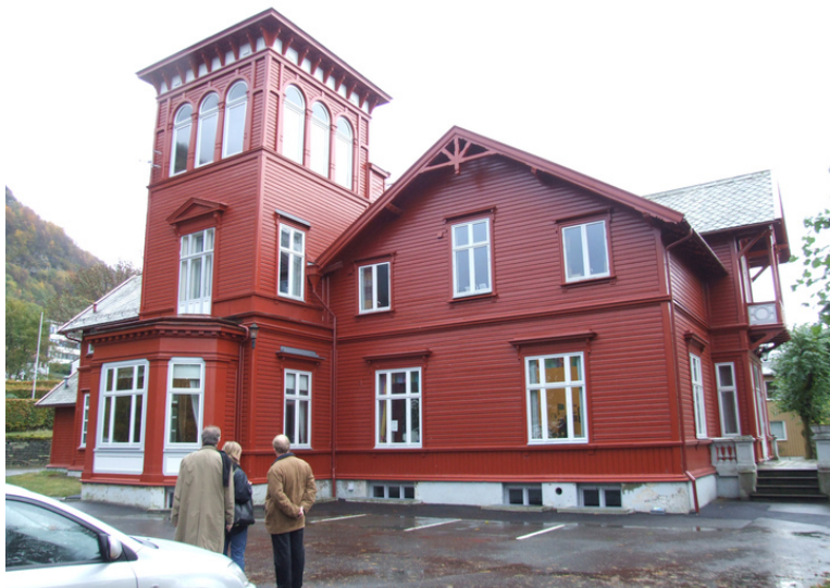
Fasade mot nordvest Foto: Leif Anker, Forsvarsbygg.
