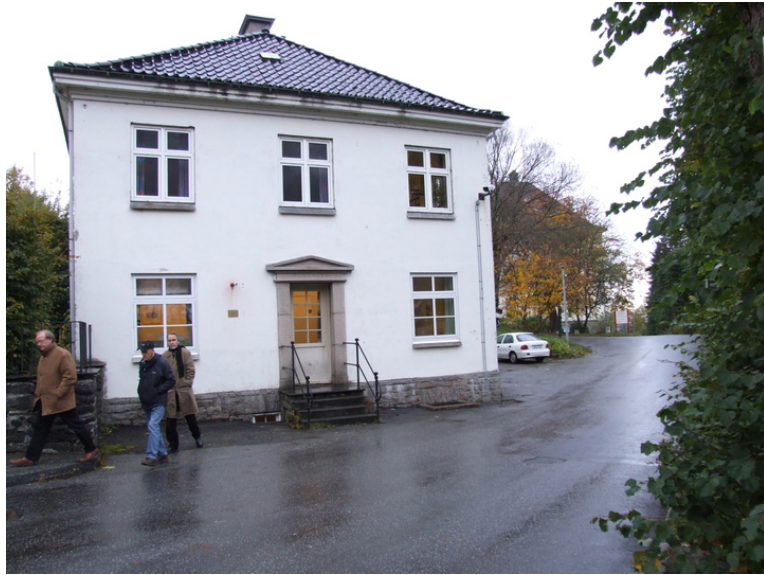
Fasde mot øst og innkjøringen. Foto: Leif Anker, Forsvarsbygg.
