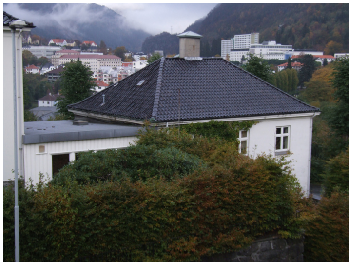
Fasade mot sør. Foto: Leif Anker, Forsvarsbygg.
