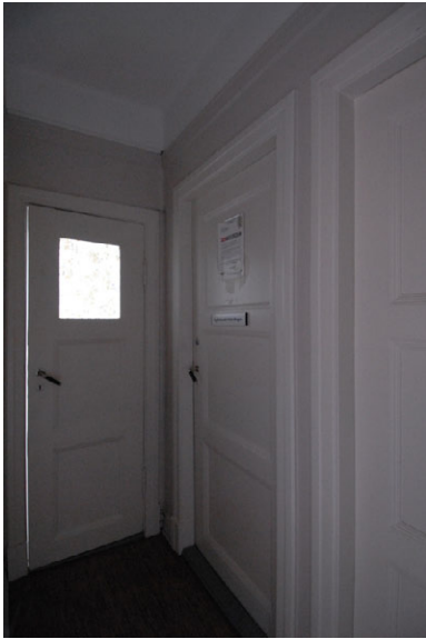
Mellomgang 2. etg mot nord. Foto: Leif Anker, Forsvarsbygg.
