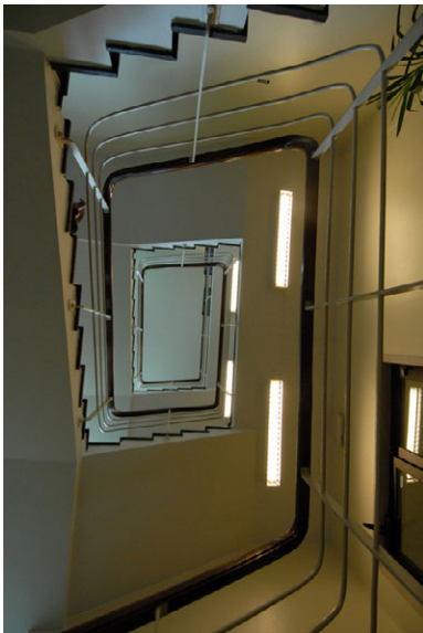
Trappehus mot loft. Foto: Leif Anker, Forsvarsbygg.
