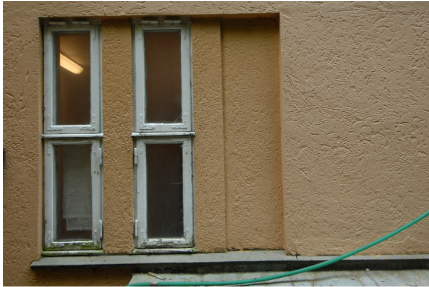
Opprinnelige vinduer østfasade. Foto: Leif Anker, Forsvarsbygg.
