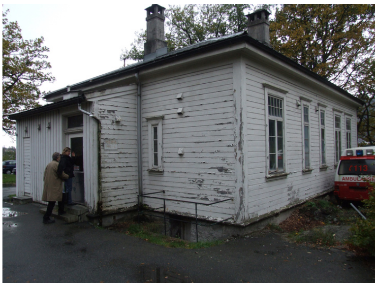
H-bygget fra nordøst. Foto: Leif Anker, Forsvarsbygg.
