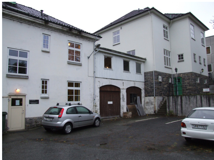
Nordfasade med påbygde garasjer. Foto: Leif Anker, Forsvarsbygg.
