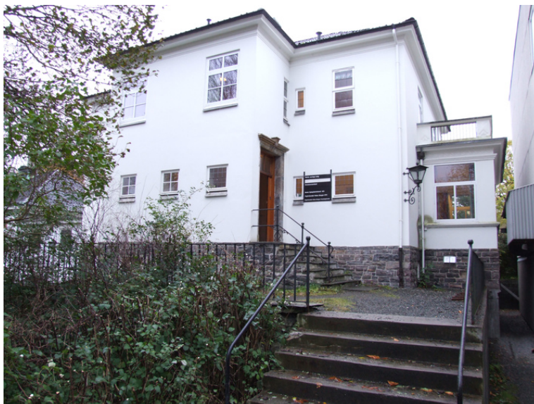
Fasade nord med hovedinngang. Foto: Leif Anker, Forsvarsbygg.
