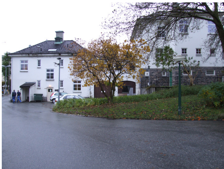
Overlegebolig t.h., nordfasade. Foto: Leif Anker, Forsvarsbygg.
