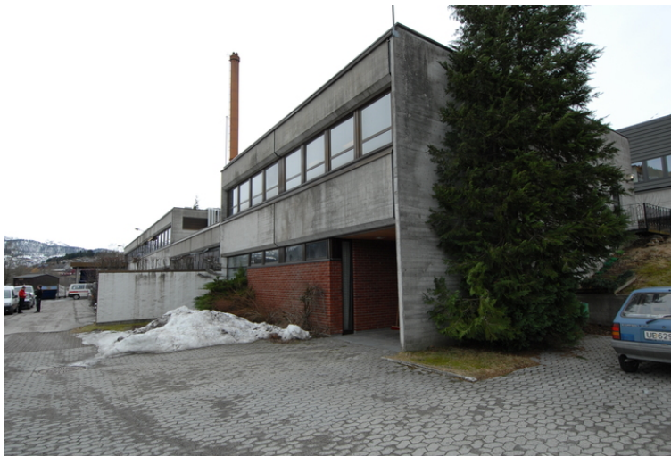
Kappelet med tegl i fasaden. Foto: Leif Anker, Forsvarsbygg.
