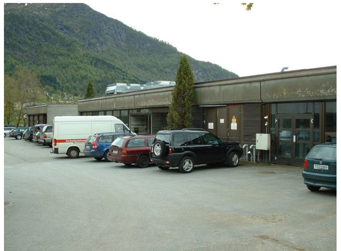
Nordfasade Foto: Helse Førde HF
