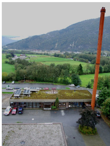
Teknisk sentral sett fra nord. Foto: Leif Anker, Forsvarsbygg.
