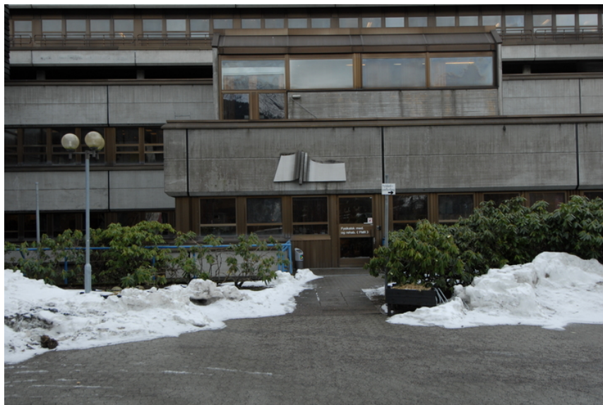
Lavblokk i nordøst med behandlingsvædeling for fysisk medisin og rehabilitering. Oppbygget i 2. etg. er auditoriet. Foto: Leif Anker, Forsvarsbygg.
