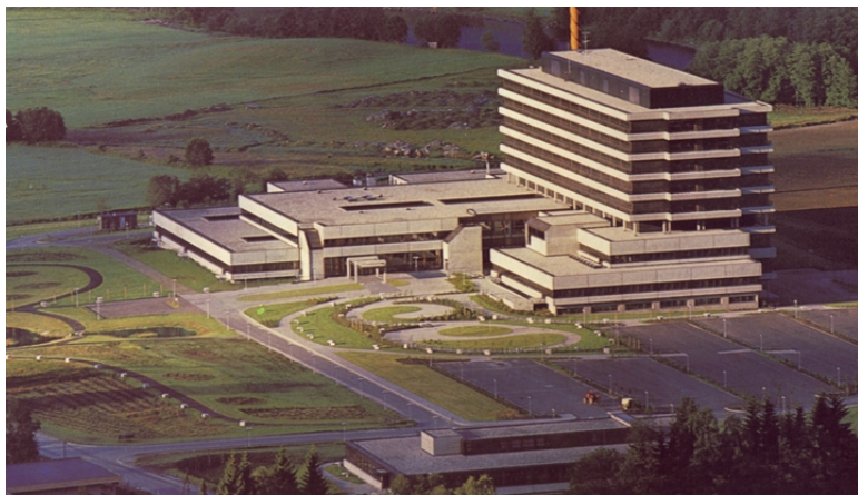
Anlegget ved ferdigstillelse. Foto: Reiakvam, Førde.
