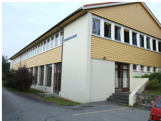
Administrasjonsbygget fra SØ. Foto: Leif Anker, Forsvarsbygg.
