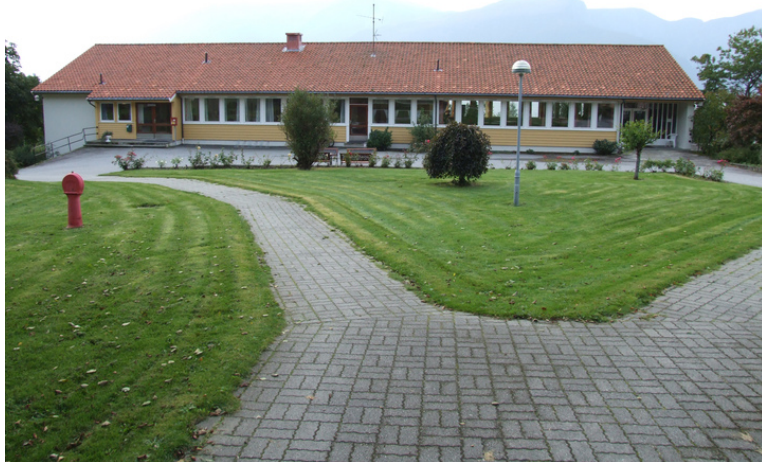
Administrasjonsbygget fra N. Foto: Leif Anker, Forsvarsbygg.
