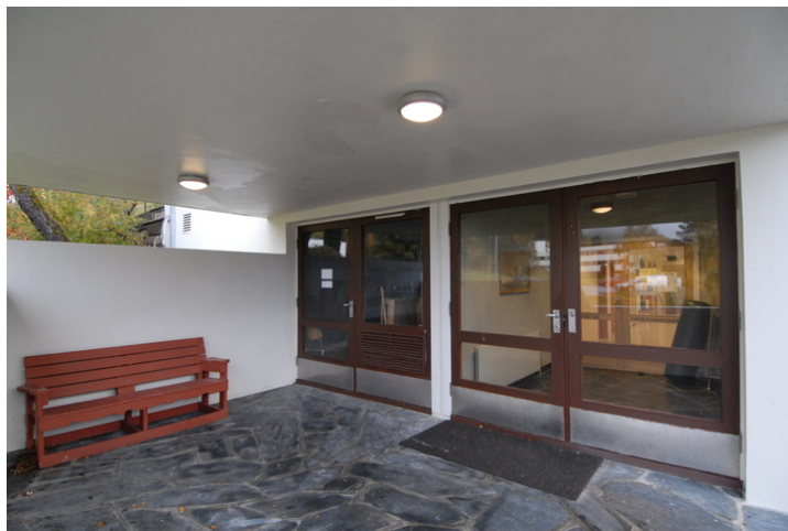
Inngangsparti sokkeletasje. Foto: Leif Anker, Forsvarsbygg.
