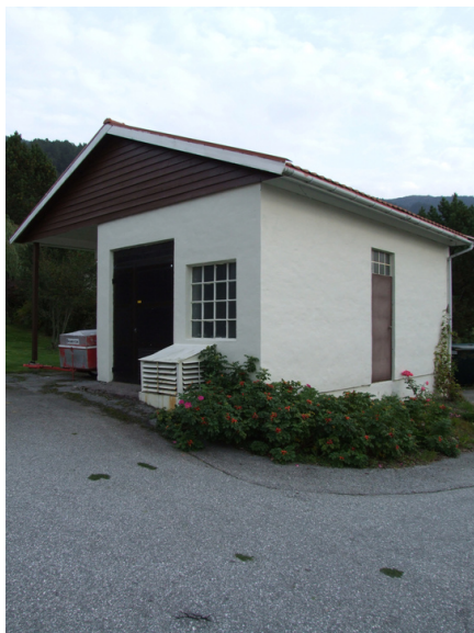
Trafobygg sett fra SV. Foto: Leif Anker, Forsvarsbygg.
