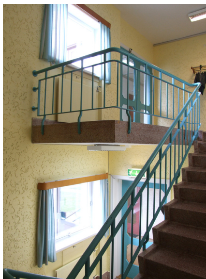
Nyere fargesetting, oppr. flater Foto: Leif Anker, Forsvarsbygg.
