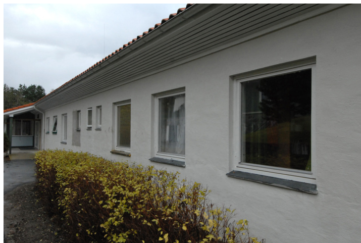
Oversiden (nordsiden) av bygningen. Foto: Leif Anker, Forsvarsbygg.
