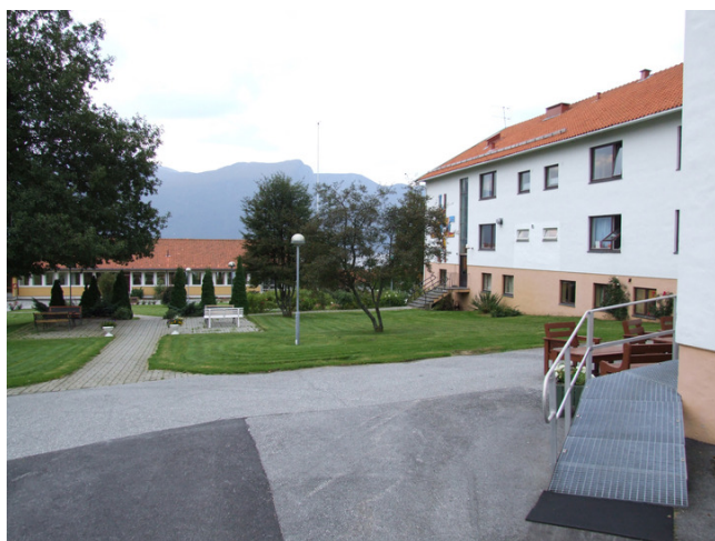
Hovedbygge og adm.bygge sett mot sør Foto: Leif Anker, Forsvarsbygge Opphavsrett:
