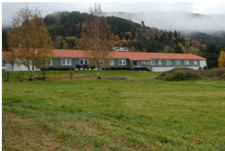
Bygningen sett fra sør. Foto: Leif Anker, Forsvarsbygg.
