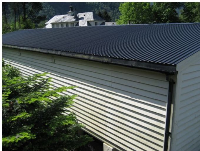
Baksiden av kurhallen. Foto: S. A. Røed, Jonatunet.
