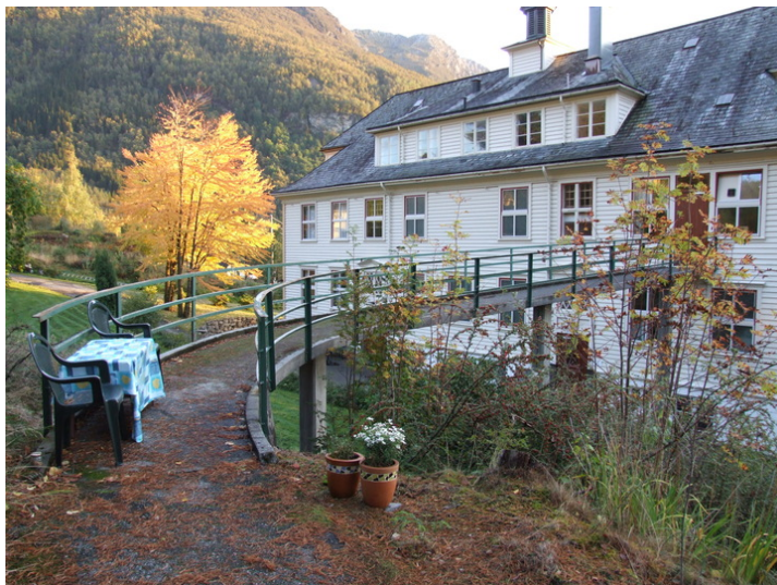
Sengebro hovedbygg. Foto: Leif Anker, Forsvarsbygg.
