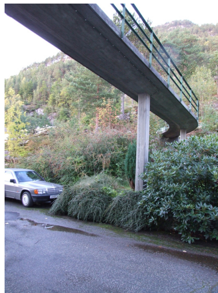
Sengebroen fra hovedfløy og ut. Foto: Leif Anker, Forsvarsbygg.
