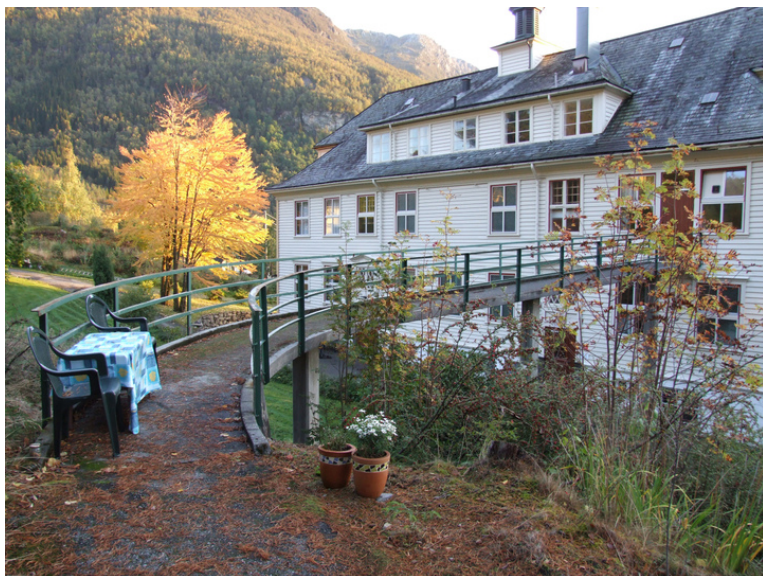
Fra baksiden av hovedfløy. Foto: Leif Anker, Forsvarsbygg.
