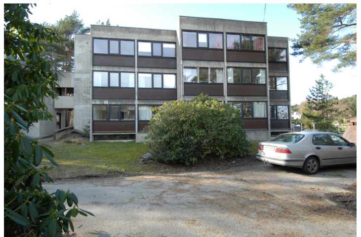
Blokk K østfasade Foto: Leif Anker, Forsvarsbygg.
