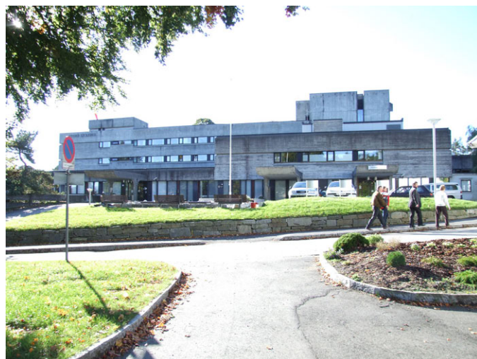
Hovedbygg fasade nord. Foto: Leif Anker, Forsvarsbygg.
