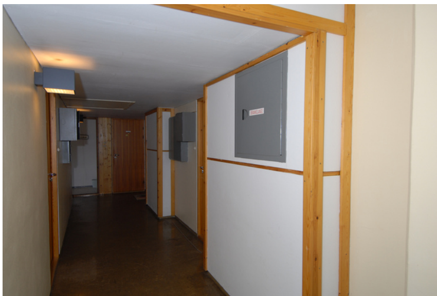
Korridor 3. etg. Foto: Leif Anker, Forsvarsbygg.
