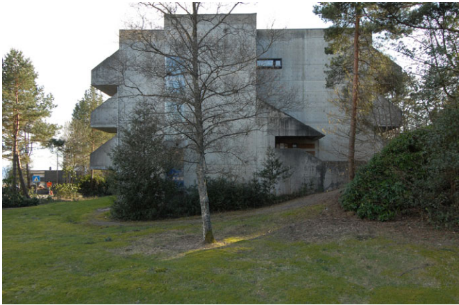
Blokk H mot nord. Foto: Leif Anker, Forsvarsbygg.
