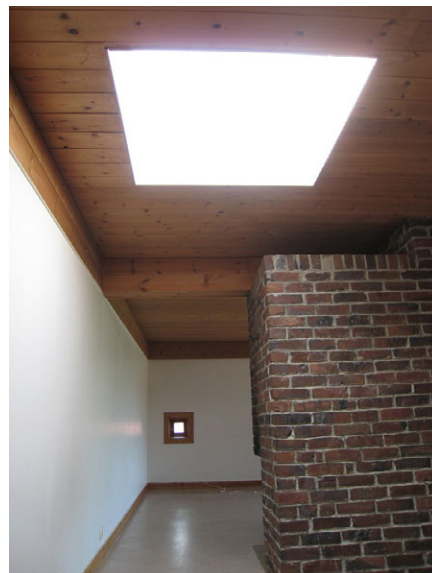
Fra stue, bakside peis og takvindu. Foto: Helse Fonna HF
