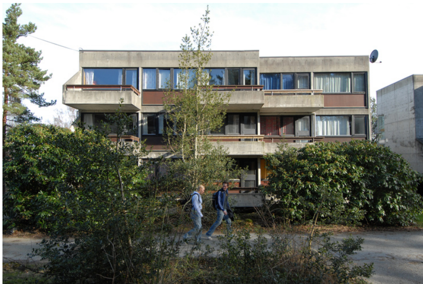
Blokk H sett fra vest. Foto: Leif Anker, Forsvarsbygg.
