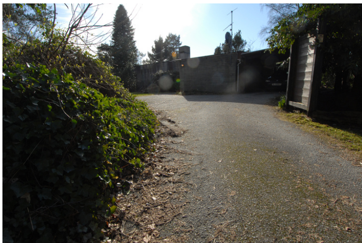
Overlegebolig B. Foto: Leif Anker, Forsvarsbygg.
