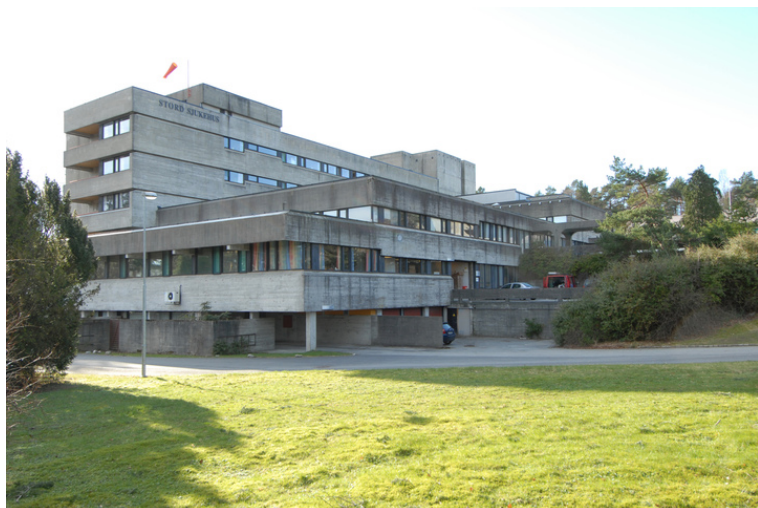
Hovedbygget sett fra nordøst. Foto: Leif Anker, Forsvarsbygg.
