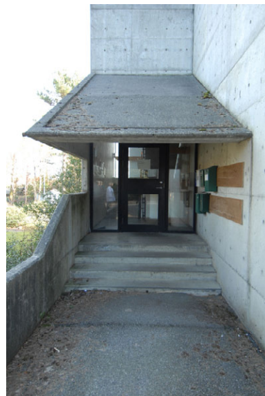
Baldakin inngangsparti. Foto: Leif Anker, Forsvarsbygg.
