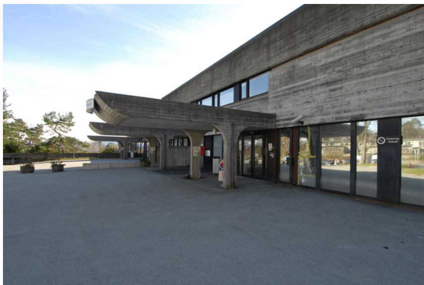
Hovedbygg nordfasade. Foto: Leif Anker, Forsvarsbygg.
