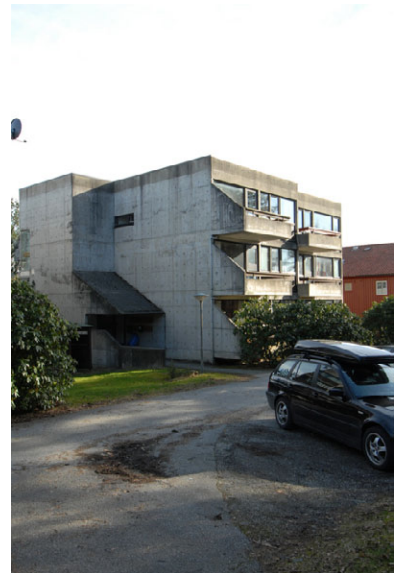
Blokk G nordvest. Foto: Leif Anker, Forsvarsbygg.
